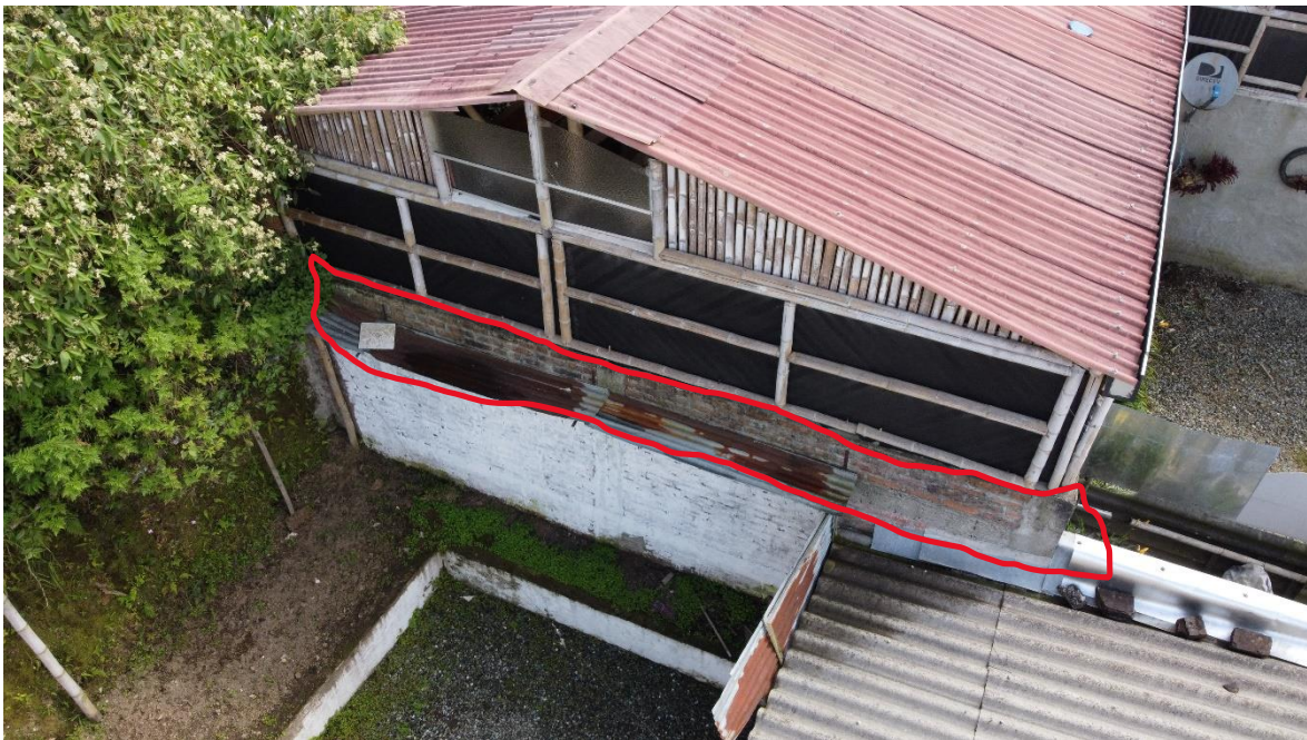
VISTA AÉREA DEL MURO DEL PREDIO DE LA DEMANDANTE Y DE LA CONSTRUCCIÓN SOBRE EL
