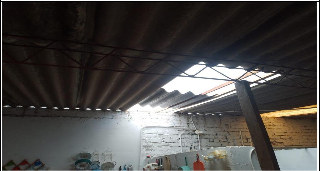
Detalle de cubierta. Eternit y cercha metálica.
