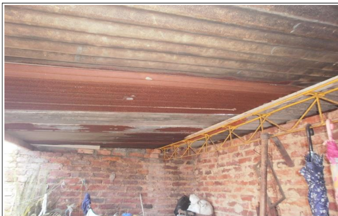
IMAGEN No. 7 DE 18 FECHA: 14/9/2021 CONTIENE: Cubierta parte posterior
