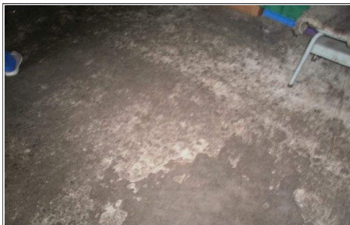
IMAGEN No. 16 DE 18 FECHA: 14/9/2021 CONTIENE: Acabado pisos
