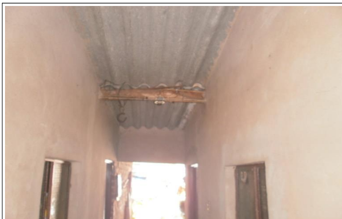
IMAGEN No. 8 DE 18 FECHA: 14/9/2021 CONTIENE: Pasillo de acceso
