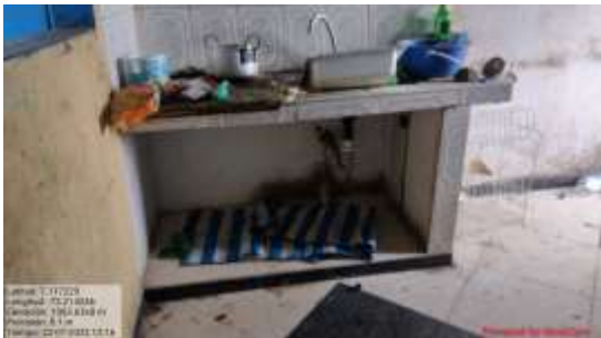
COCINA EN EL SEGUNDO NIVEL
