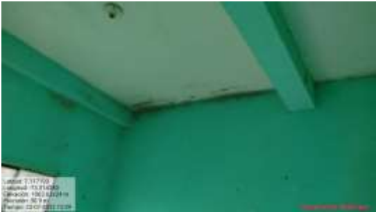
PAREDES CON HUMEDAD
