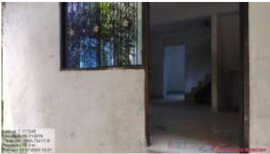
PUERTA DE INGRESO
