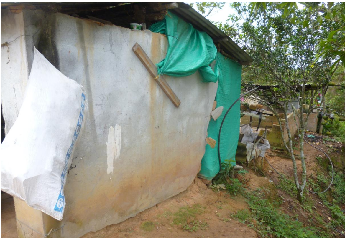
Parte trasera de la propiedad con riesgo de desplome
