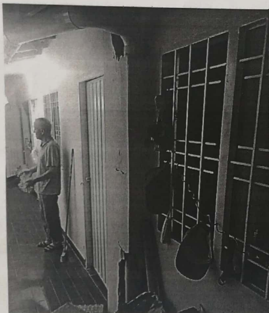
Foto No. 7. Evidencia tuberías colindante
