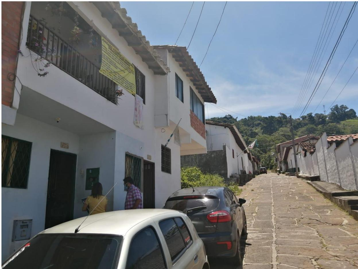
En el año 2013 se aprecia el inmueble ya deteriorado por humedad en su parte baja y en su cubierta, por lo que No se considera muy reciente su construcción.
