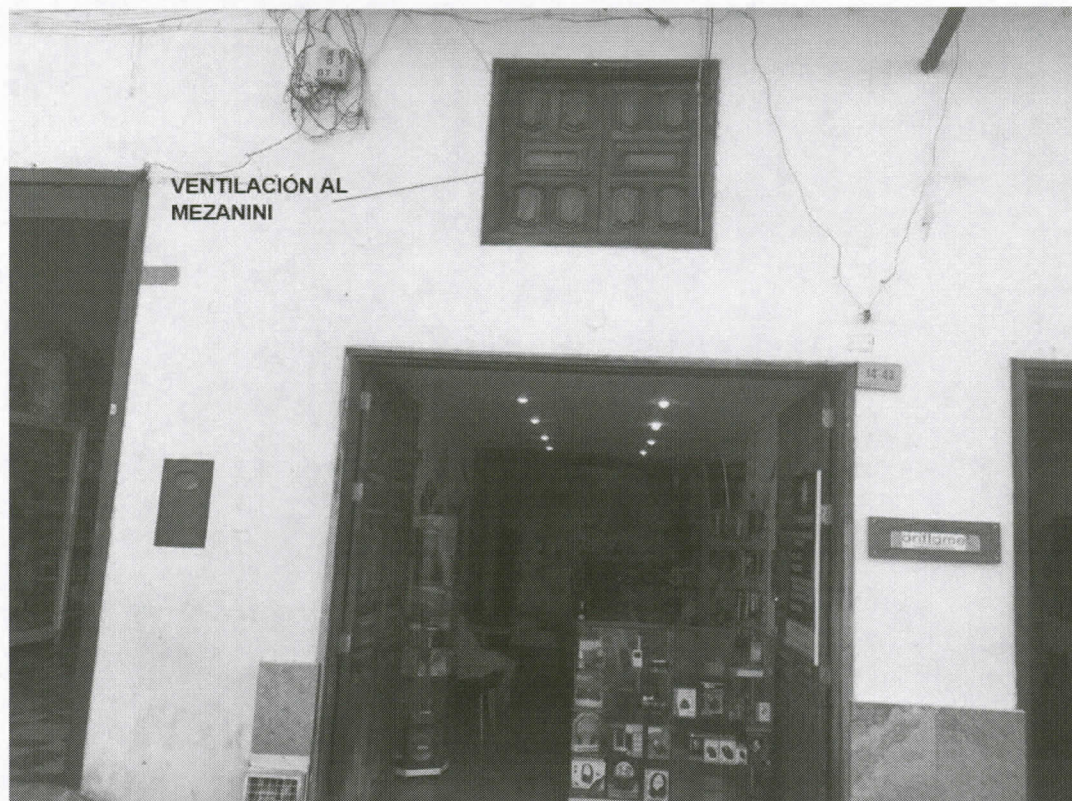
ILUSTRACIÓN 1: ENTRADA PRINCIPAL AL LOCAL CALLE 12 # 14-43
