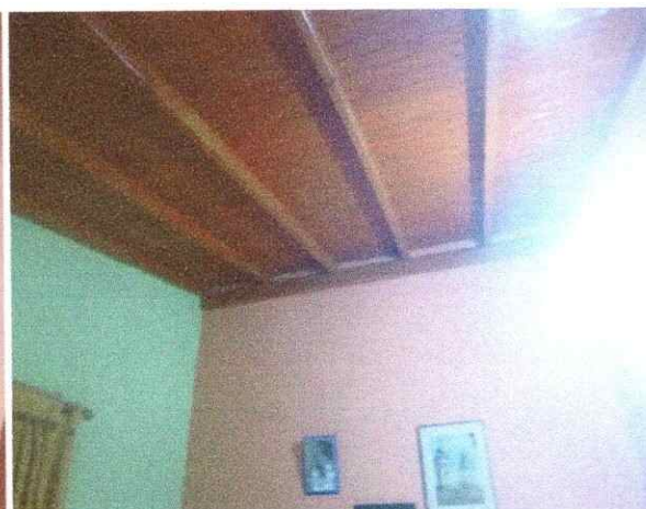
Foto No. 6. Techo, machimbre
