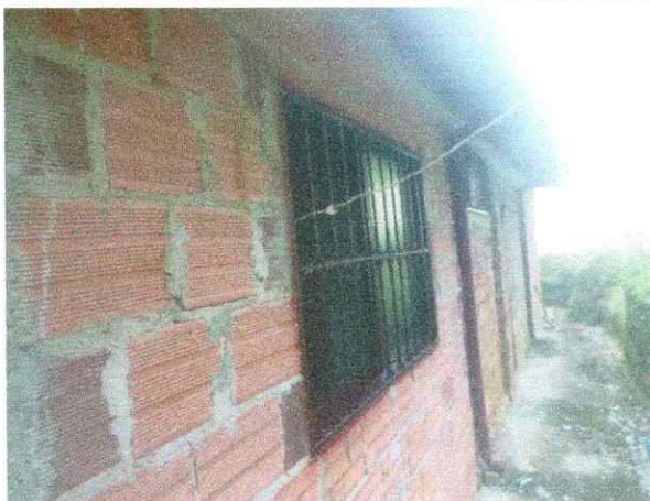
Foto No. 9. Ventana metálica
