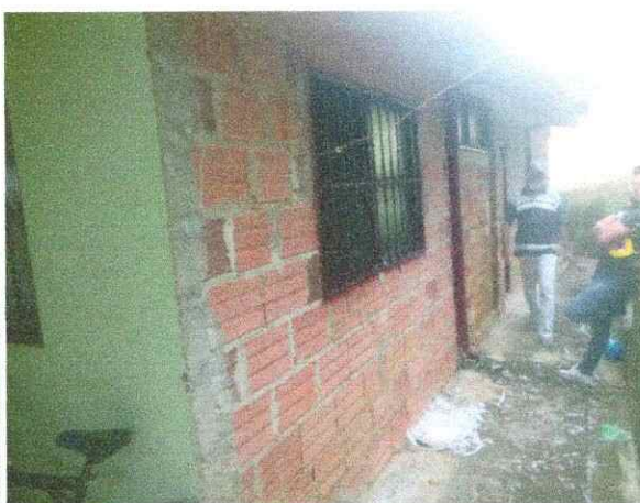
Foto No. 12. Construcción nueva
