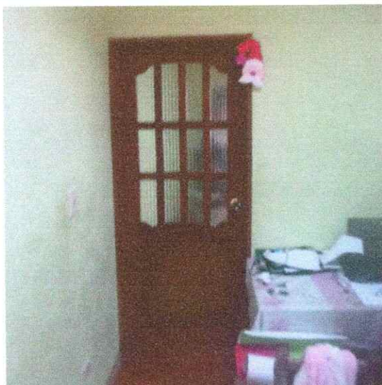
Foto No. 15. Puerta madera
