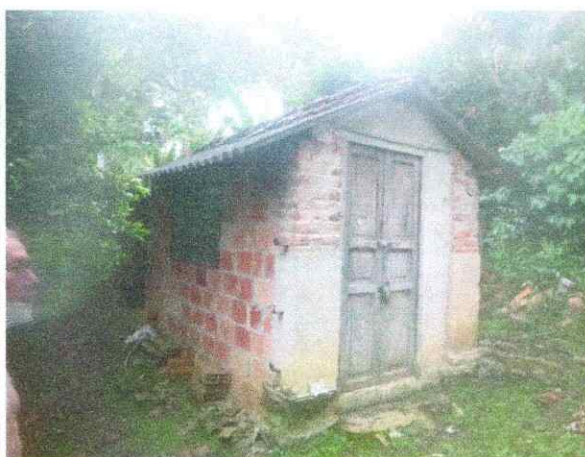
Foto No. 22. Bodega
