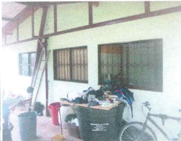
Foto No. 10. Ventanas metálicas
