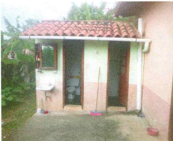
Foto No. 1. Baño
