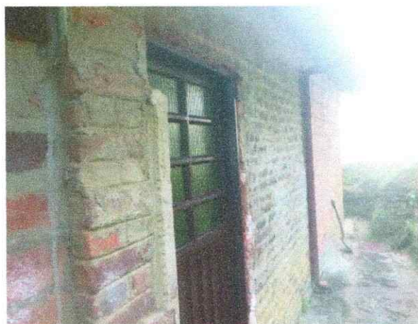
Foto No. 11. Puerta metálica
