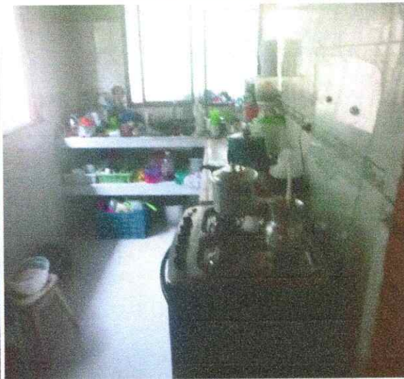
Foto No. 16. Cocina – obra nueva
