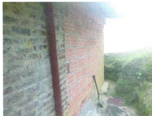
Foto No. 13. Construcción nueva
