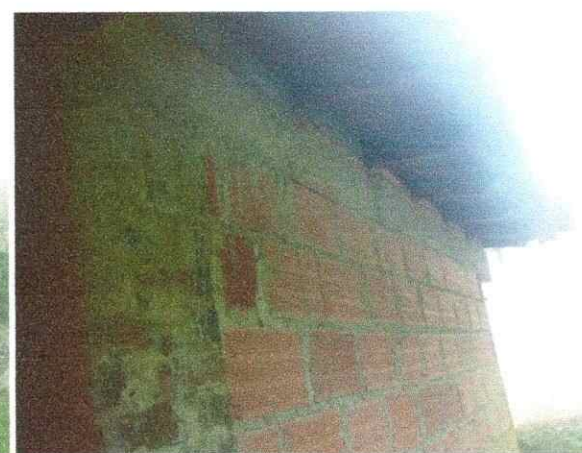
Foto No. 14. Viga perimetral
