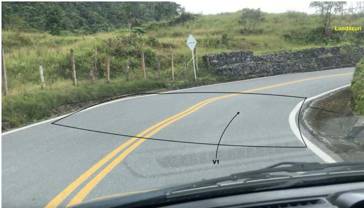
Figura 11. Panorámica de la vía con vista hacia el norte, en la trayectoria del vehículo (1) camioneta, en la cual se ilustra la deformación de la superficie vial. Imagen obtenida del video adjunto registrado durante la inspección al lugar de los hechos por parte del suscrito perito.
