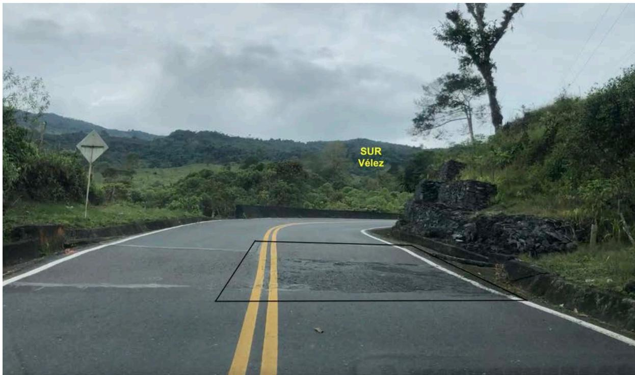
Figura 12. Panorámica de la vía con vista hacia el sur, en la trayectoria del vehículo (2) motocicleta, en la cual se ilustra la deformación de la superficie vial. Imagen obtenida del video adjunto registrado durante la inspección al lugar de los hechos por parte del suscrito perito.
