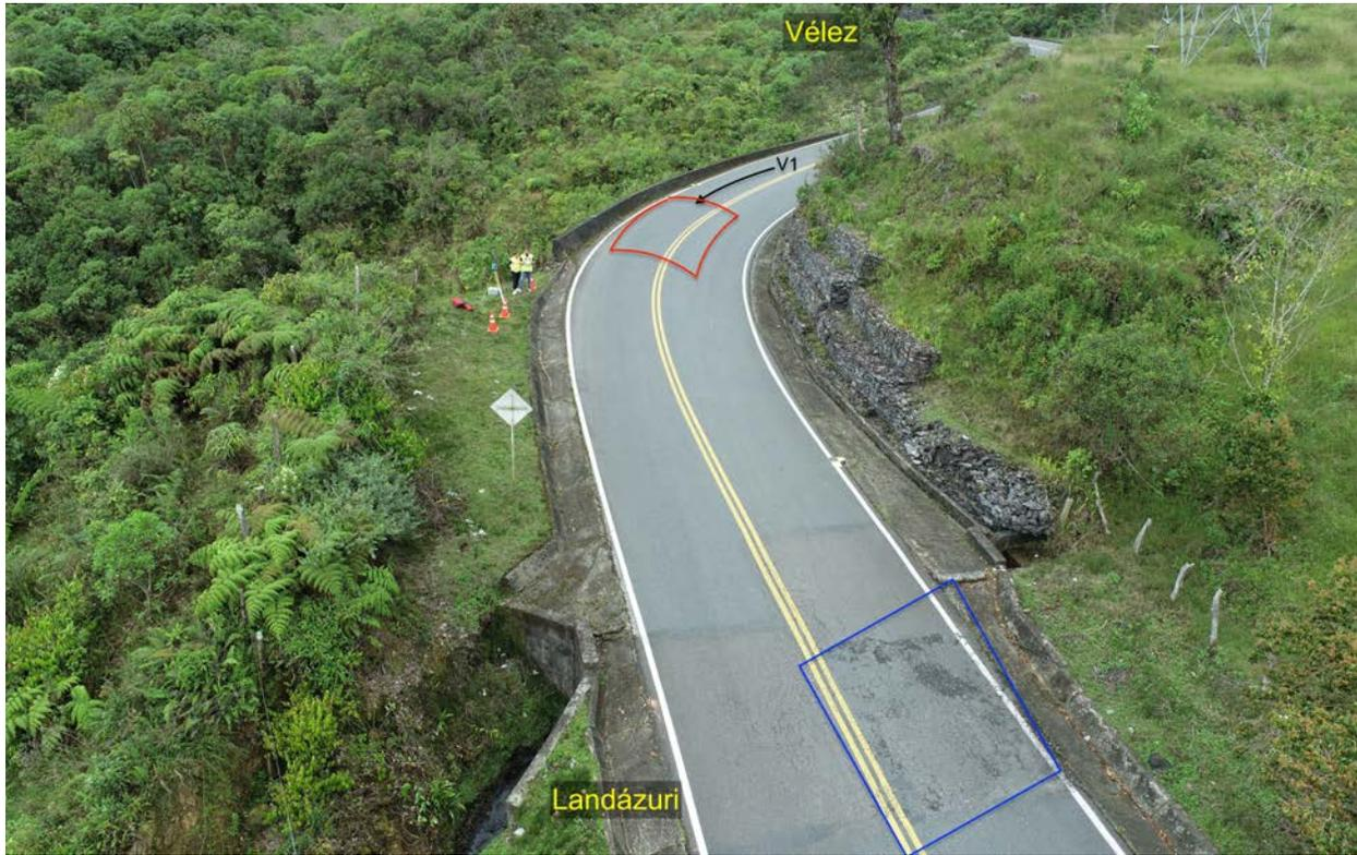
Figura 9. Panorámica de la vía con vista hacia el sur, en la trayectoria del vehículo (2) motocicleta. El recuadro azul ilustra el área de depresión en el carril de circulación de la motocicleta. El recuadro rojo ilustra el área de la posición final de los EMP y EF.
