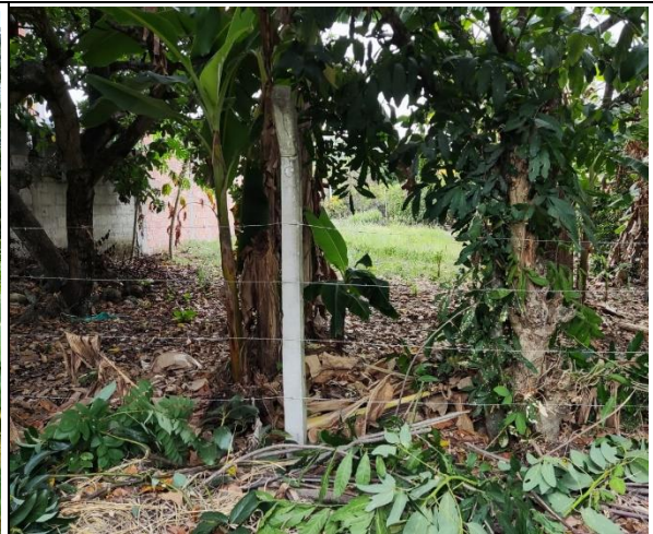
Vista cerca perimetral con postes existentes
