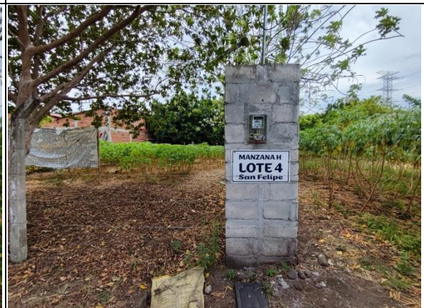
Vista vértice suroccidental del predio - acometida eléctrica y caja del medidor.
