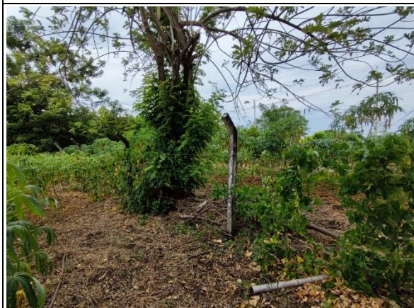
Vista cerca perimetral con postes existentes
