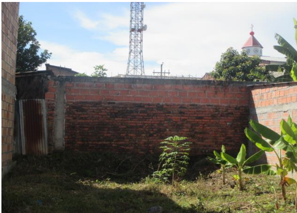
Lindero costado Occidental
