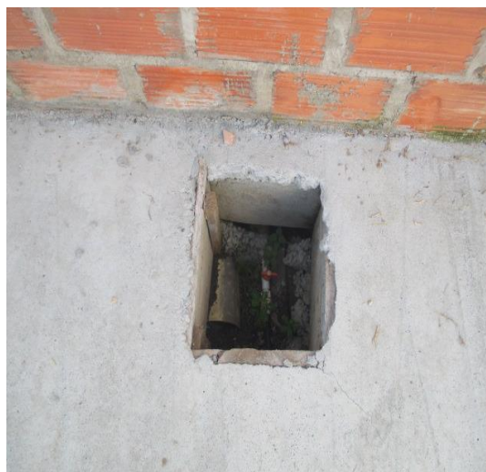
Caja de registro alcantarillado y Contador del Servicio de Acueducto
