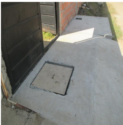
Caja de registro alcantarillado y Contador del Servicio de Acueducto
