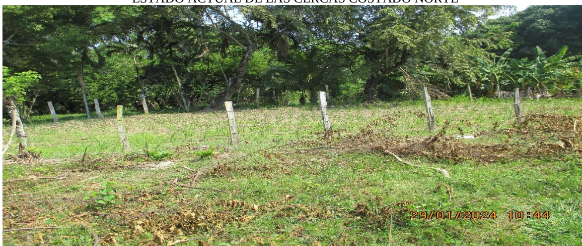
ESTADO ACTUAL DE LAS CERCAS COSTADO NORTE
