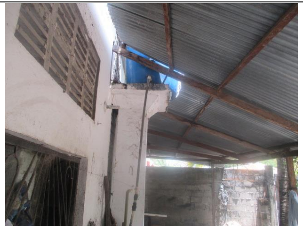
cubierta con estructura de masera y tejas de Eternit y zinc
