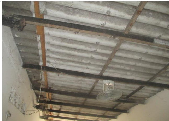
cubierta con estructura de masera y tejas de Eternit y zinc
