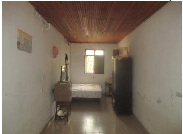
Bodegas pisos y cielo raso en amachimbre y pisos en mineral amarillo
