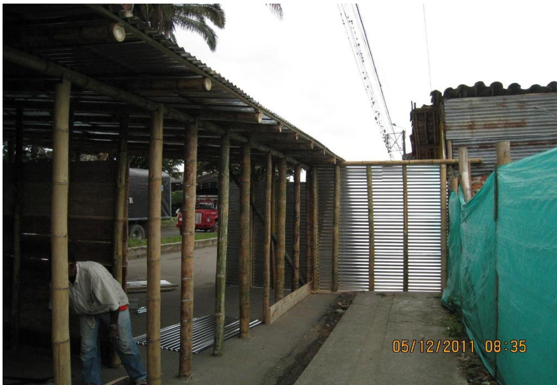
Foto No 8: Construcción area de bodega de almacenamiento materiales.
