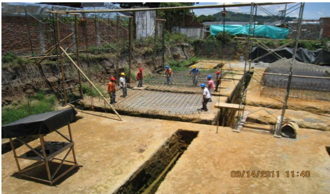
FOTO No.6: UBICACIÓN DE MALLAS DENTRO DE LOS BARROTES DE CIMENTACION
