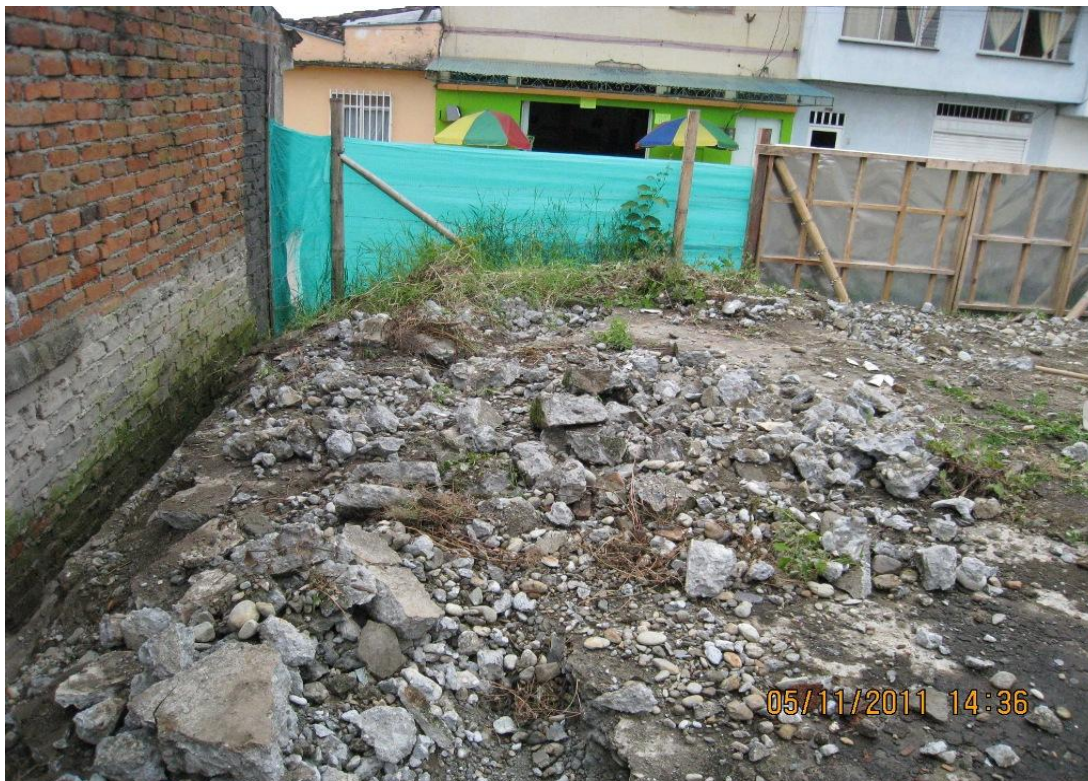
Foto No 4: Demolición placa de concreto.
