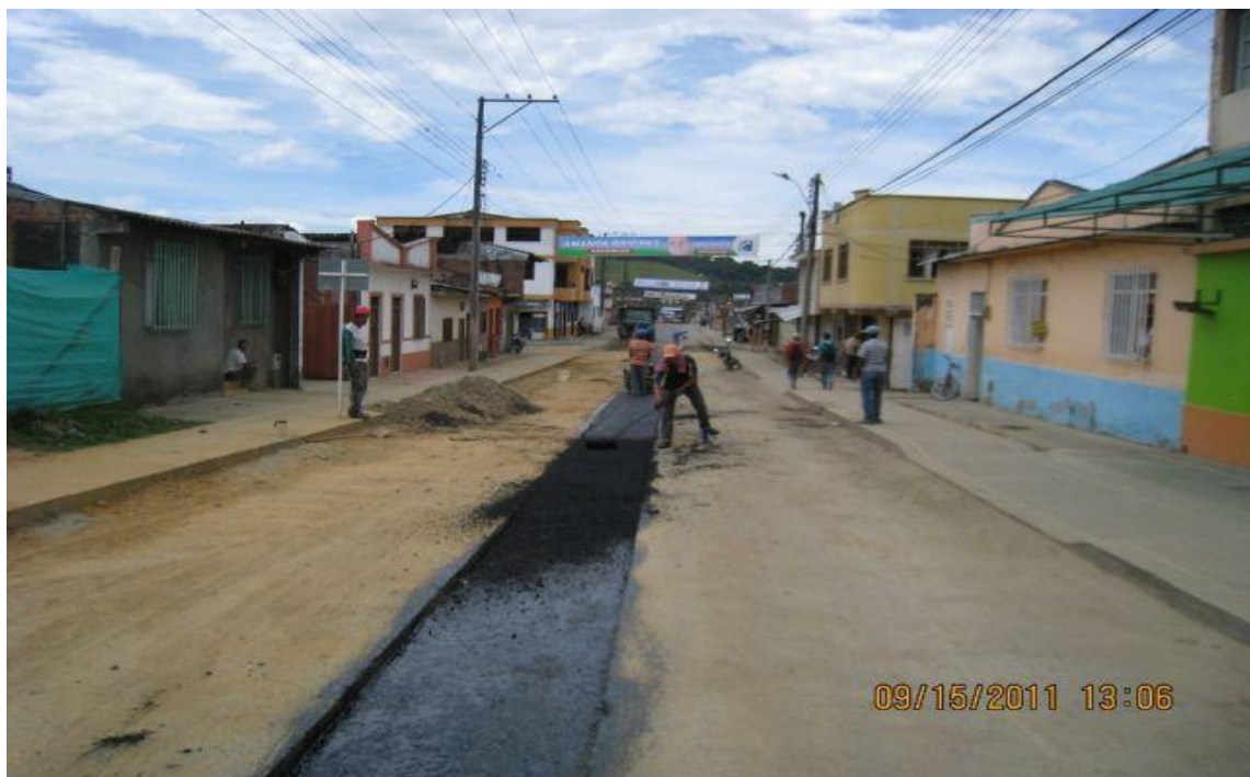
FOTO No.15: REGADO Y COMPACTACION DE LA CARPETA ASFALTICA REPOSICIÓN ALCANTARILLADO CRA 14 PROYECTO TORRES DEL CENTENARIO
