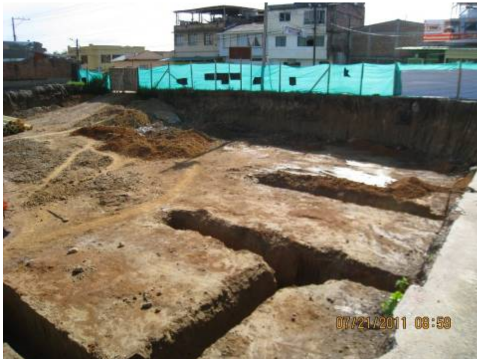
FOTO No1: EXCAVACIÓN MECÁNICA BARRETES DE CIMENTACIÓN – MÓDULO 3 (EJES H, F Y D)
