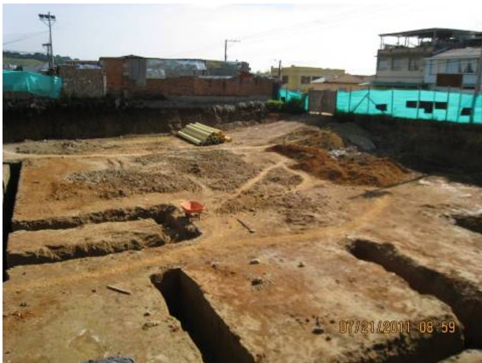
FOTO No 2: EXCAVACIÓN MECÁNICA BARRETES FOSO ASCENSOR – MÓDULO 4.
