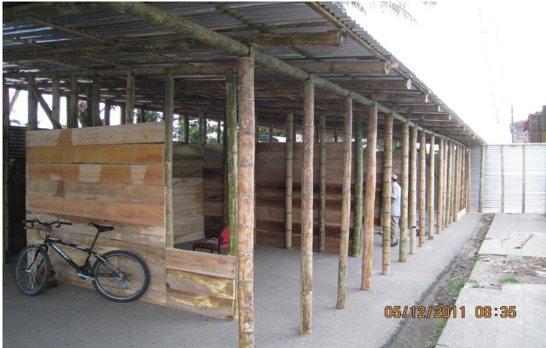
Foto No 7: Construcción area de oficinas de ingenieros.
