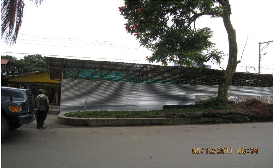
Foto No 5: Construcción campamento, sobre la calle 13.
