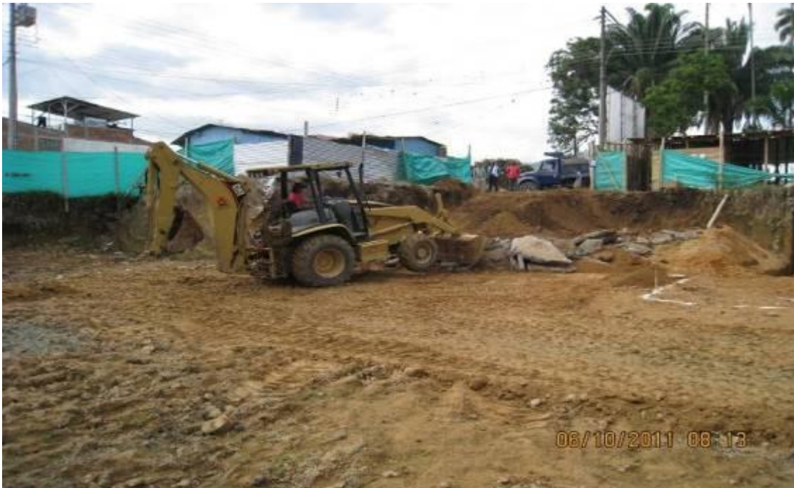
FOTO No 2: EXCAVACIÓN MECÁNICA PARA SÓTANO.
