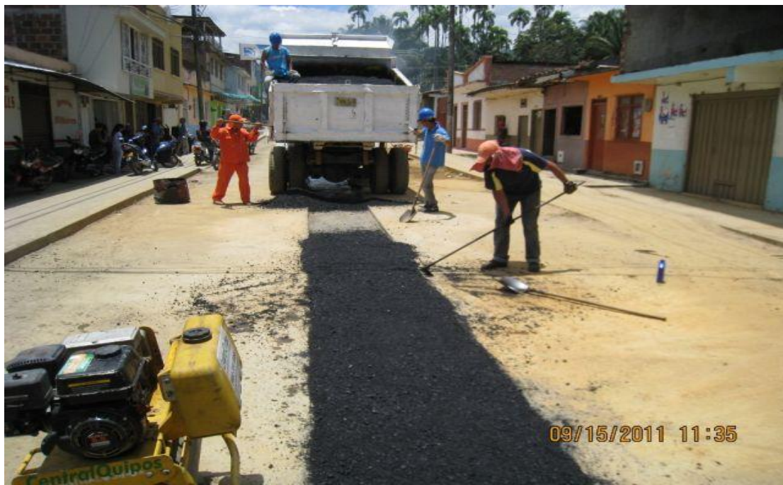
FOTO No.9: REGADO DE LA CARPETA ASFALTICA REPOSICIÓN ALCANTARILLADO CARRERA 14. PROYECTO TORRES DEL CENTENARIO
