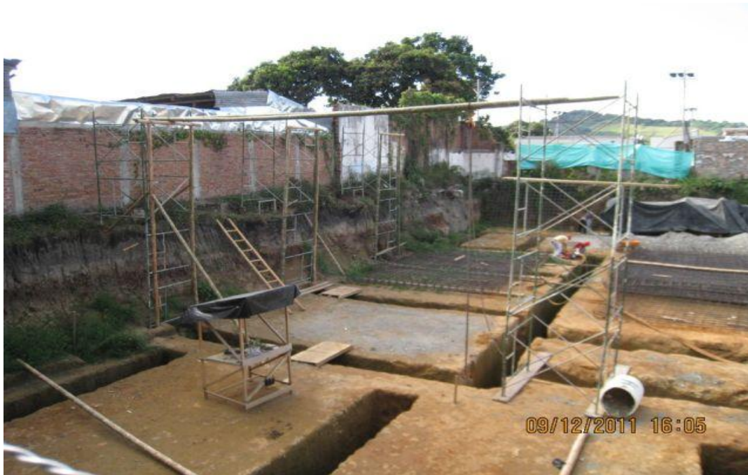
FOTO No.3: CONSTRUCCIÓN DE ANDAMIOS PARA UBICACIÓN DE DIFERENCIALES.
