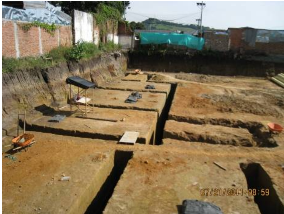
FOTO No 3: EXCAVACIÓN BARRETES DE CIMENTACIÓN – MÓDULO 4
