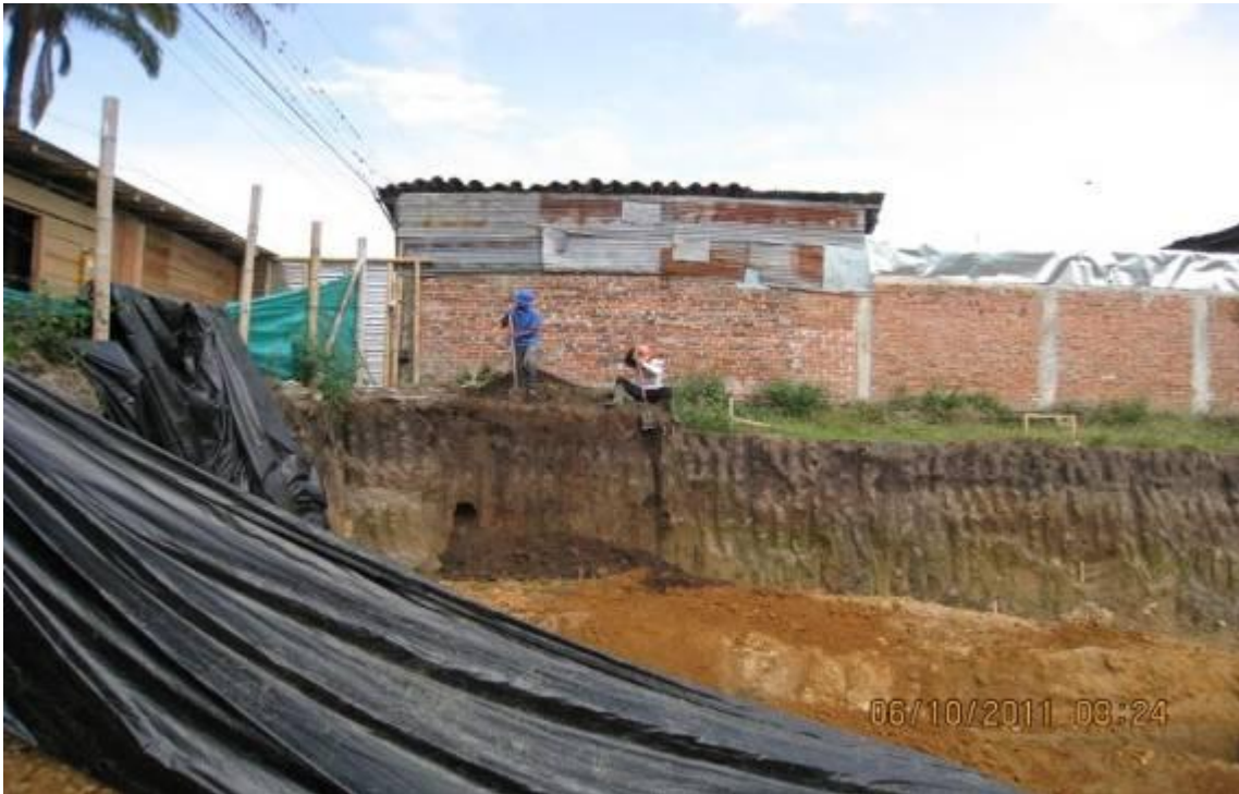
FOTO No 3: PERFILADO MANUAL DE TALÚDES
