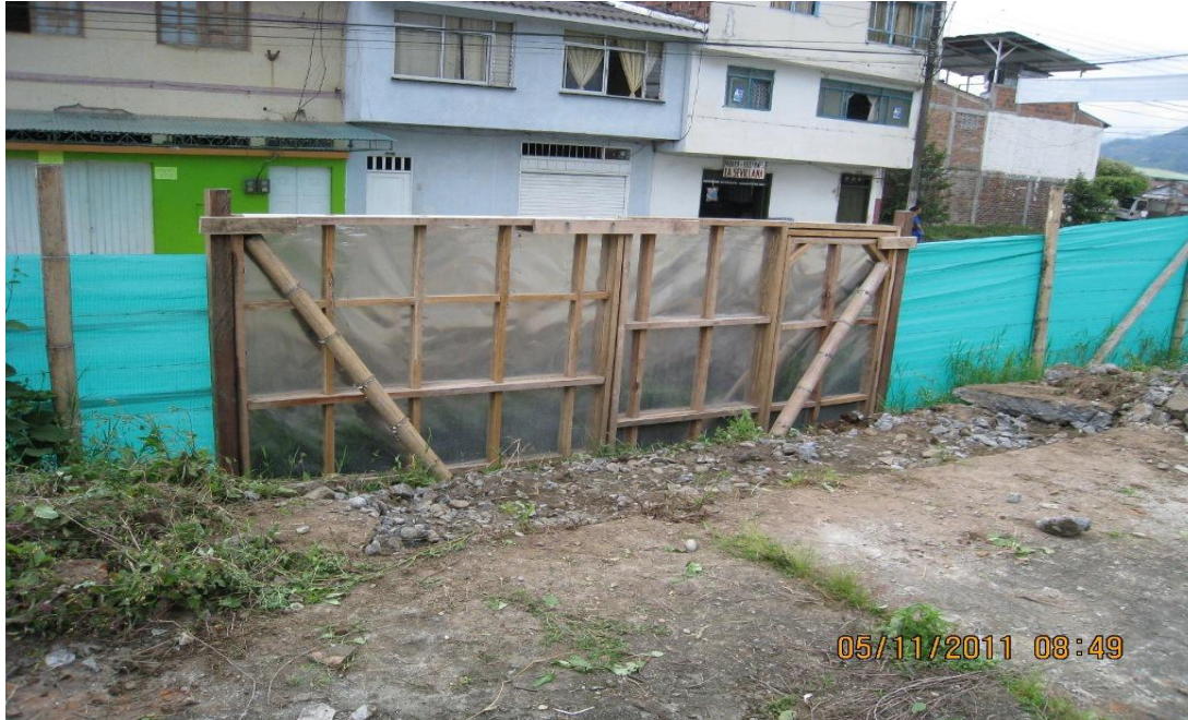
Foto No 3: Puerta de acceso obra.
