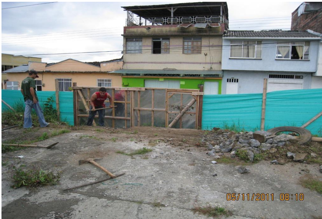
Foto No 2: Demolición placa de concreto.
