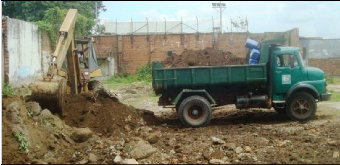
Imagen 05 – Inicio de Obras Lanzamiento e Inicio de Obra Torres del Centenario
