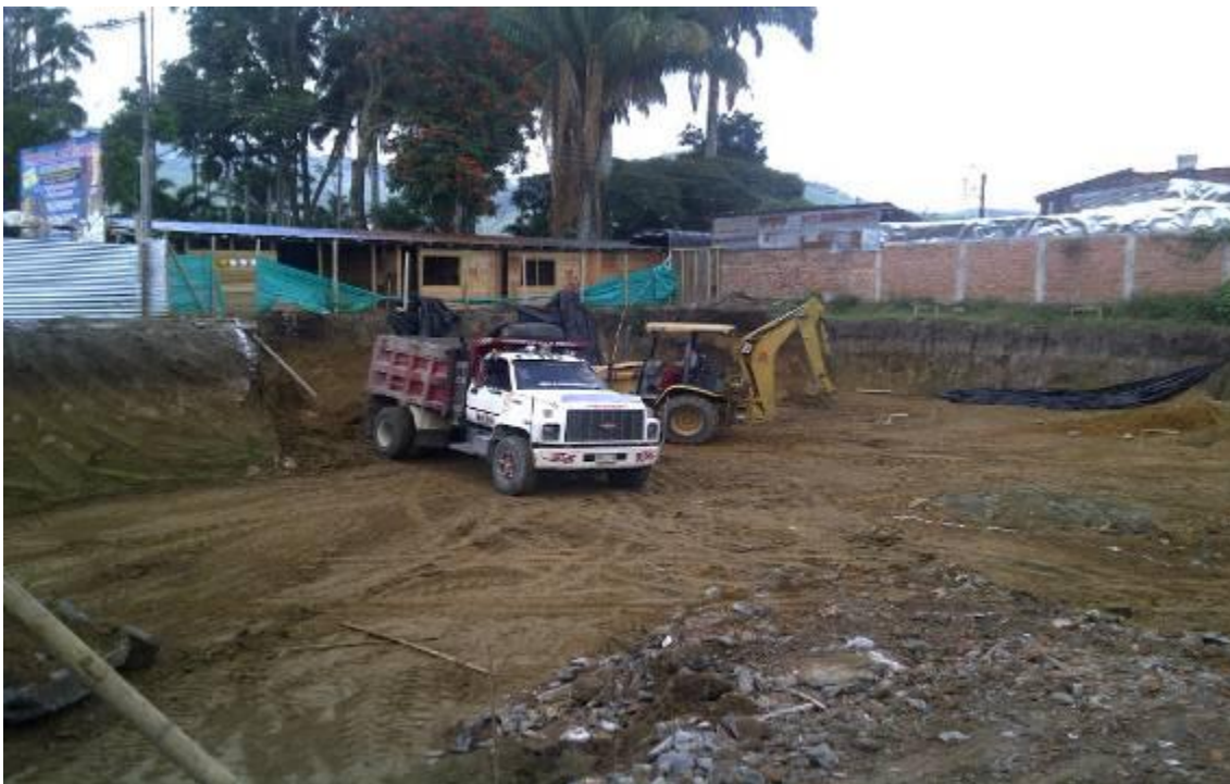
FOTO No 10: CARGUE Y RETIRO DE MATERIAL SOBRANTE DE EXCAVACIÓN
