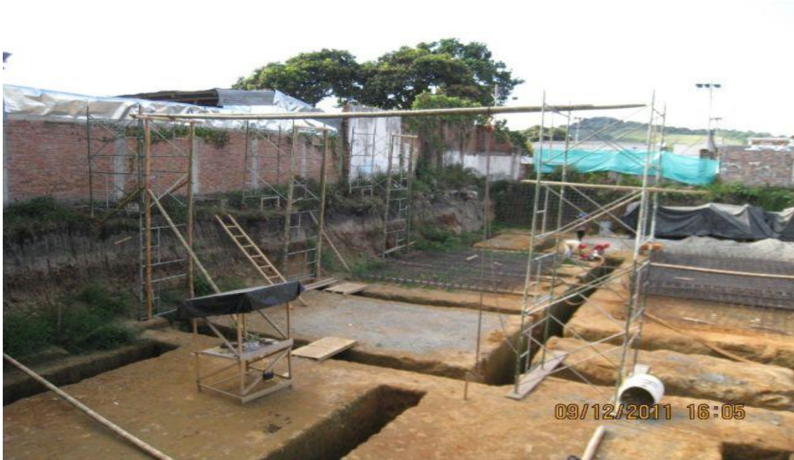
FOTO No.5: LEVANTAMIENTO DE MALLAS Y UBICACIÓN DENTRO DEL BARROTE.
