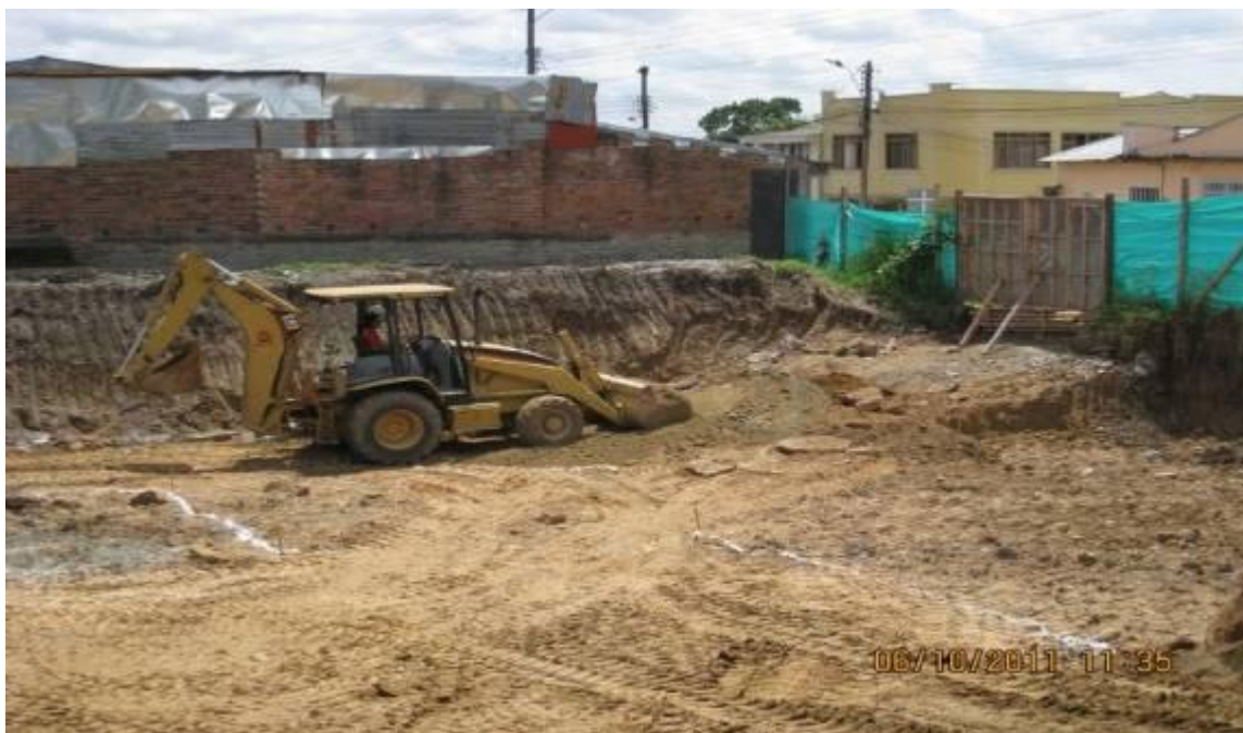
FOTO No 6: ADECUACIÓN RAMPA ACCESO SOBRE CARRERA 14.
