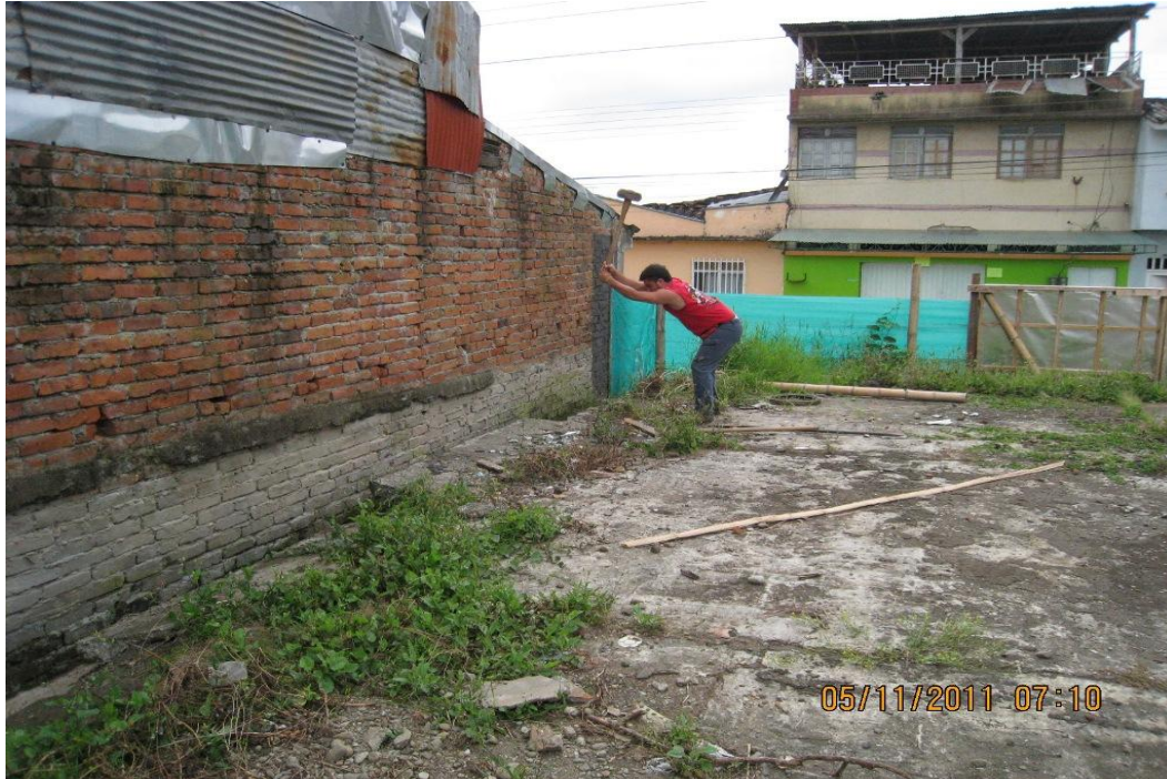
Foto No 1: Demolición placa de concreto.
