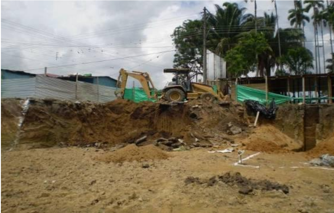
FOTO No1: EXCAVACIÓN MECÁNICA PARA SÓTANO.
