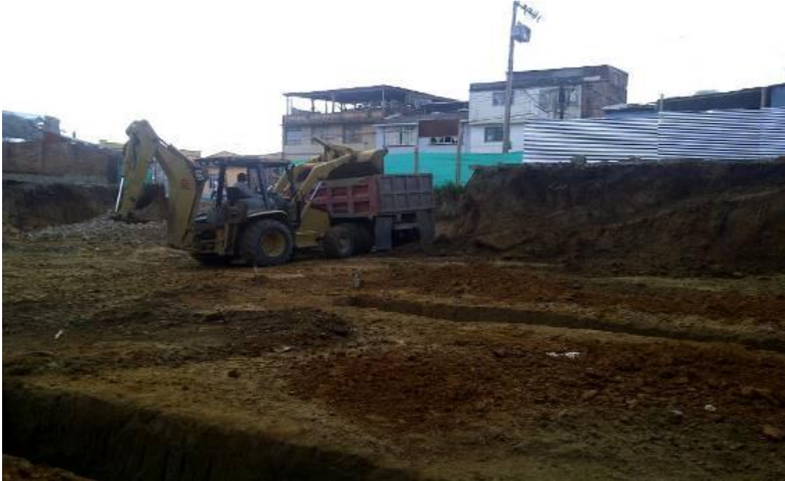
FOTO No 9: CARGUE Y RETIRO DE MATERIAL SOBRANTE DE EXCAVACIÓN.
