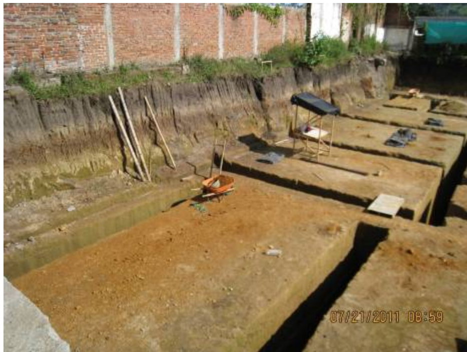
FOTO No 4: EXCAVACIÓN BARRETES DE CIMENTACIÓN – MÓDULOS 3 Y 4
