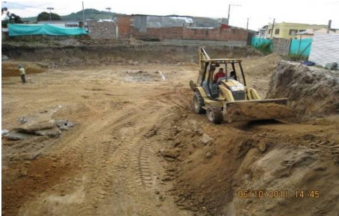
FOTO No 7: CONFORMACIÓN RAMPA PROVISIONAL ACCESO SOBRE CALLE 13.
