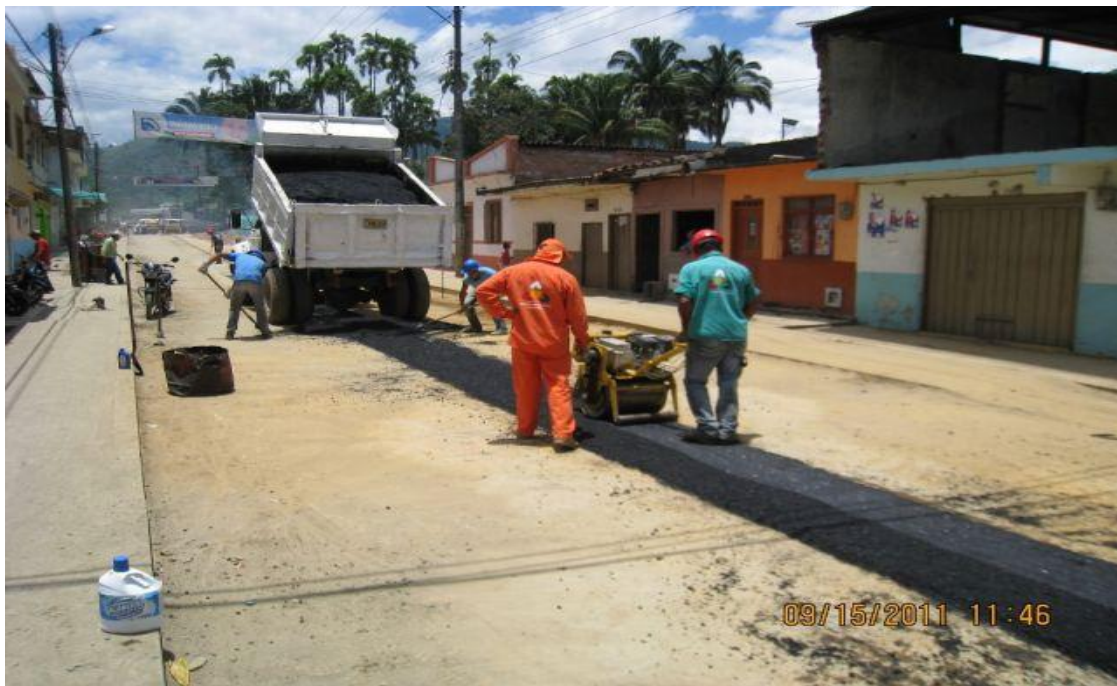
FOTO No.8: COMPACTACION DE LA CARPETA ASFALTICA CON CILINDRO PROYECTO TORRES DEL CENTENARIO
