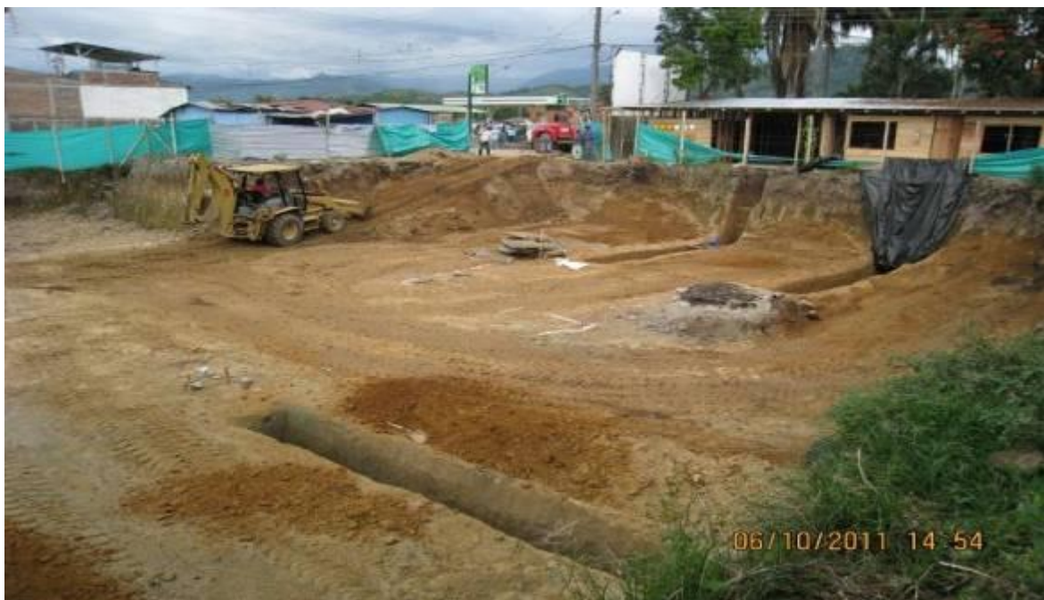
FOTO No 8: CONFORMACIÓN RAMPA PROVISIONAL ACCESO SOBRE CALLE 13 Y EXCAVACIÓN MANUAL PARA BARRETES DE CIMENTACIÓN.
