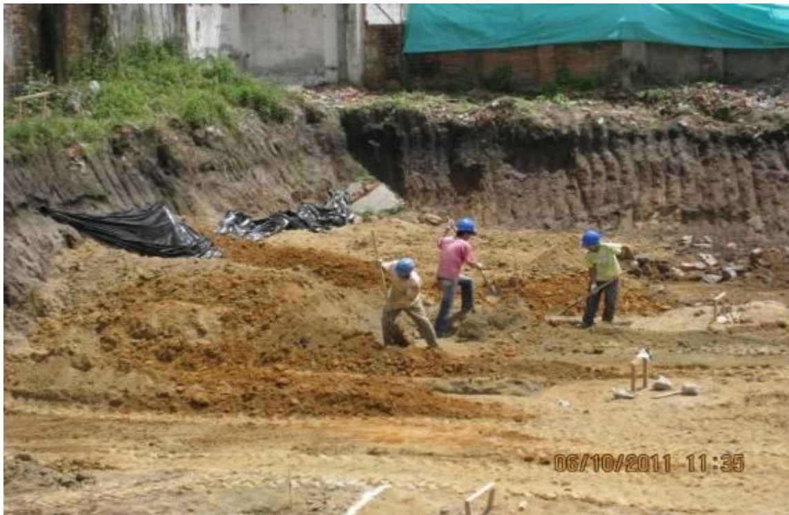
FOTO No 5: EXCAVACIÓN MANUAL PARA CIMENTACIÓN.
