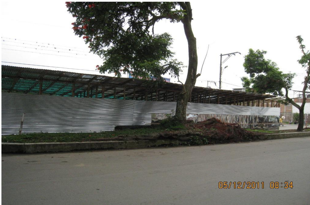
Foto No 6: Construcción campamento, sobre la calle 13.
