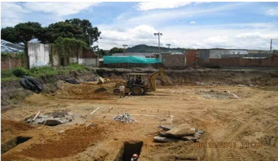
FOTO No 4: EXCAVACIÓN MANUAL PARA BARRETES Y CONFORMACIÓN MECÁNICA DE TERRERNO.
