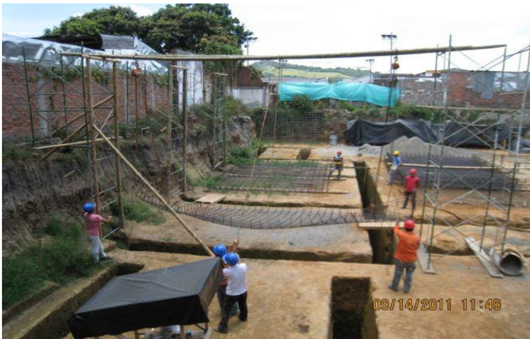
FOTO No.4: LEVANTAMIENTO DE MALLAS CON DIFERENCIALES
