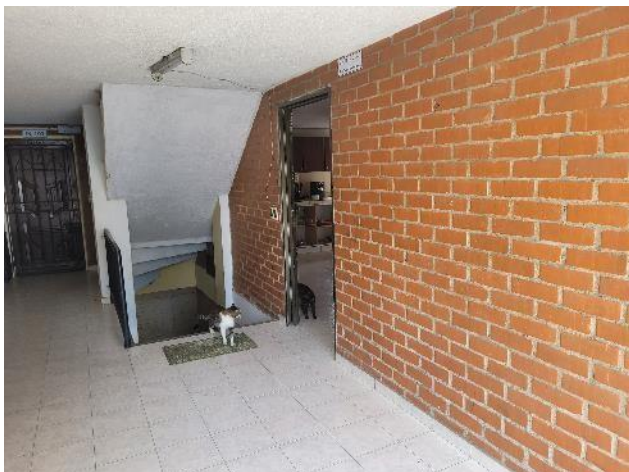
INGRESO A APARTAMENTO
