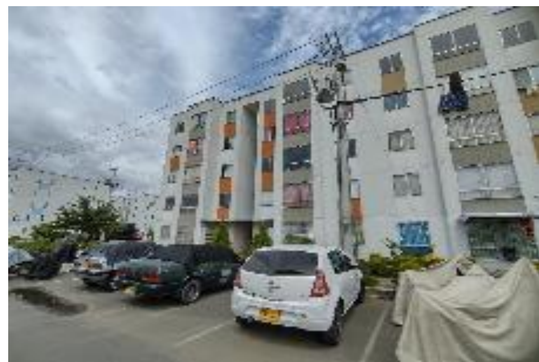
FACHADA BLOQUE 6 EDIFICIO B
