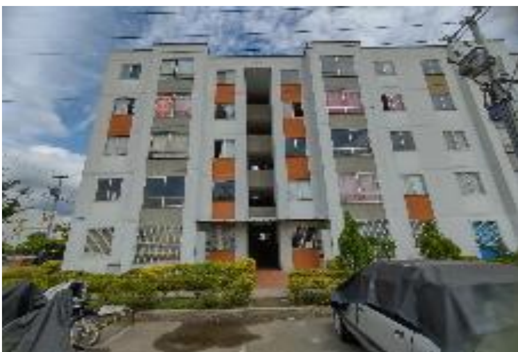
FACHADA BLOQUE 6 EDIFICIO B
