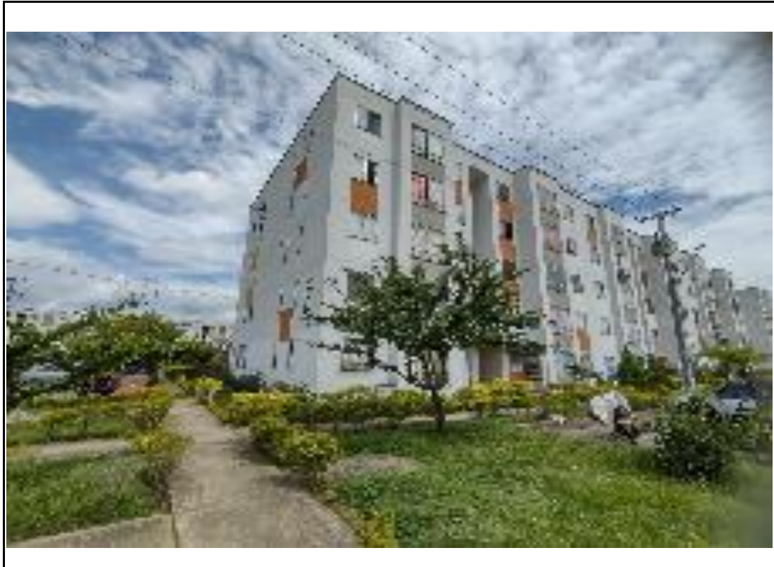
FACHADA EDIFICIO B BLOQUES 4-5-6
