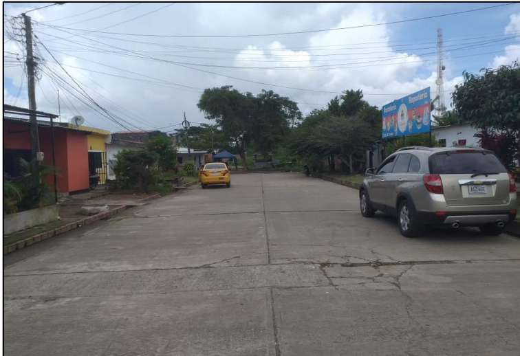
VIA DE ACCESO CALLE 18
