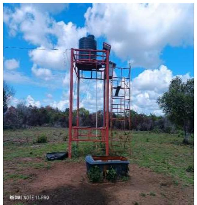
Figura 48. Tanque elevado en estructura metálica.
