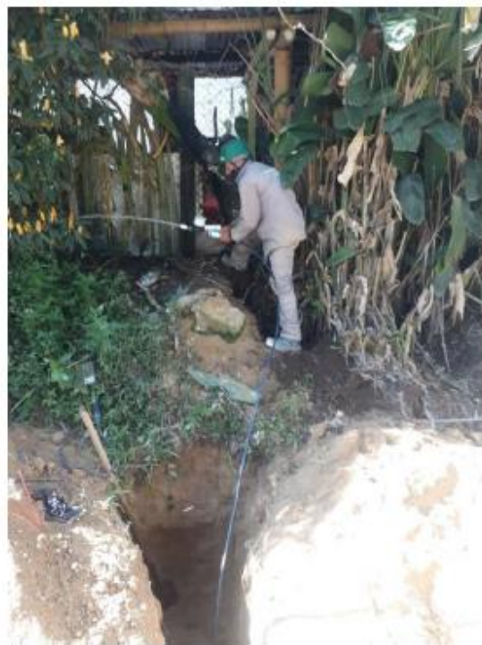
INSTALACIÓN DEL SERVICIO PROVISIONAL DE ACUEDUCTO
