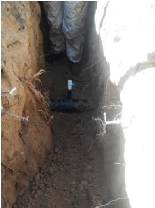
INSTALACIÓN DEL SERVICIO PROVISIONAL DE ACUEDUCTO
