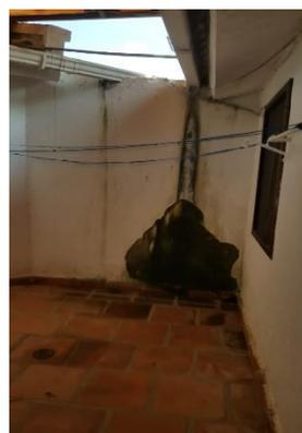
Impremeabilización general de muros expuestos a la interperie.
