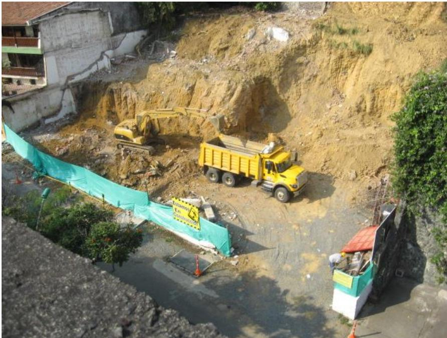
**IMAGEN 1.** Esta imagen demuestra que en la excavación del **EDIFICIO KAوبا**, no había nivel freático, por lo tanto, el agua que aparece en las paredes de los parqueaderos en el costado oriental, no son provenientes de este. El nivel freático en este lugar está a 20.0 metros de profundidad. El nivel freático viene marcado por la profundidad que alcanza la capa superior del agua acumulada en el subsuelo.
