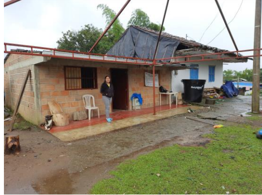
Detalle casa 2 y casa 1
