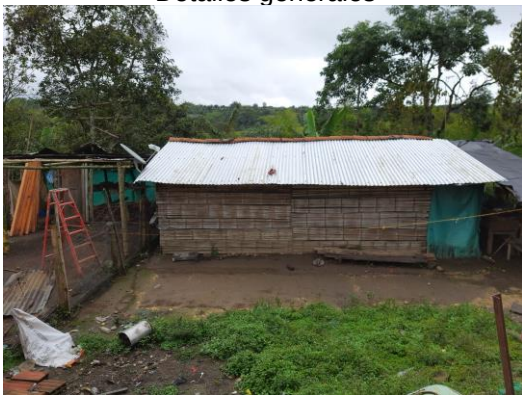
Detalle construcción en guadua
