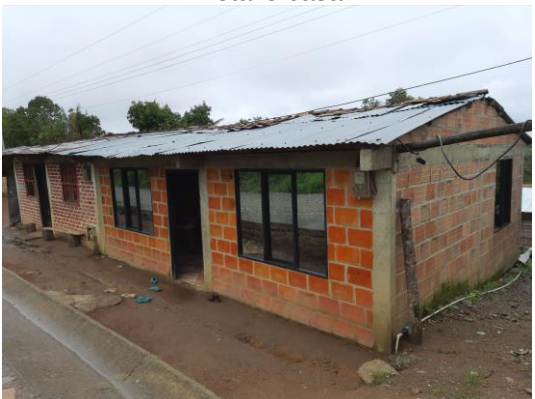
Detalle casa 6 y casa 7
