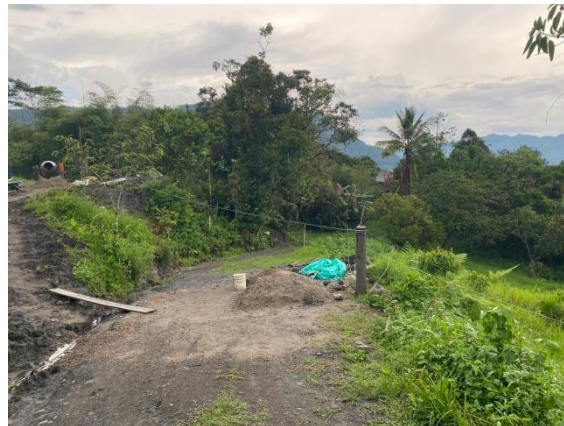
ENTRADA CONSTRUCCIÓN EN OBRA
