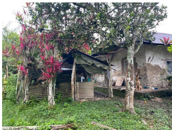
VISTA COSTADO CONSTRUCCIÓN
