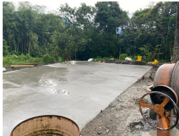
PLANCHA NUEVA CONSTRUCCIÓN
