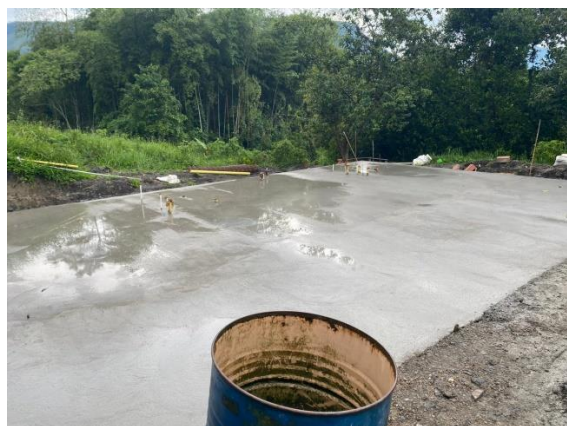
PLANCHA NUEVA CONSTRUCCIÓN
