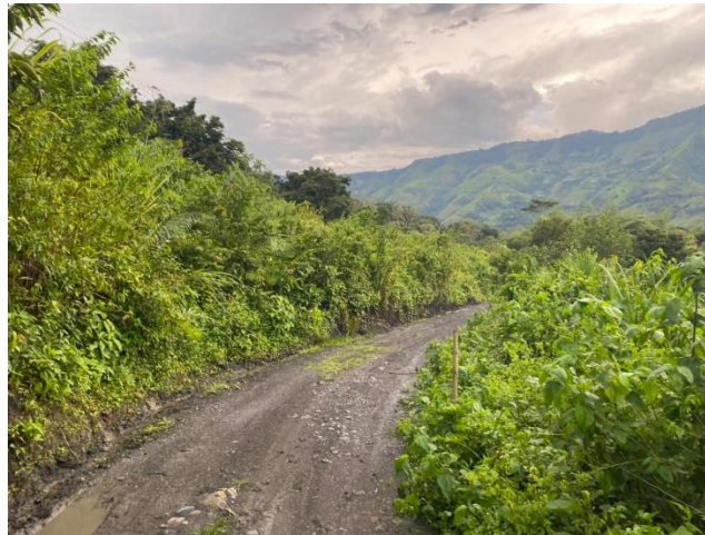
Imagen 5. Vía Interna hacía los predios.
