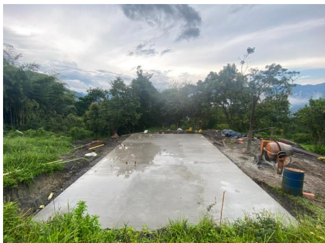
PLANCHA NUEVA CONSTRUCCIÓN
