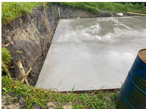
PLANCHA NUEVA CONSTRUCCIÓN
