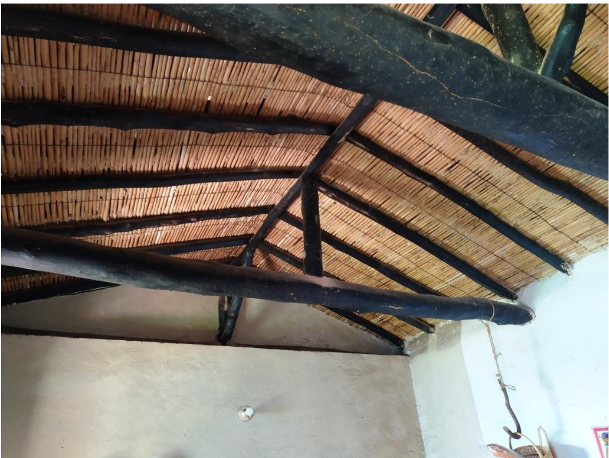
FOTOGRAFIA 9 (Casa de Habitación, Cielorraso).
