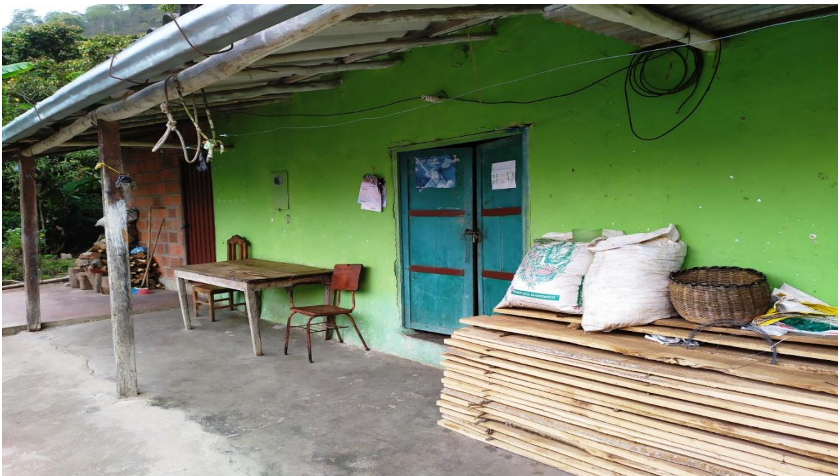
Fotografía (Exterior Casa de Habitación)
