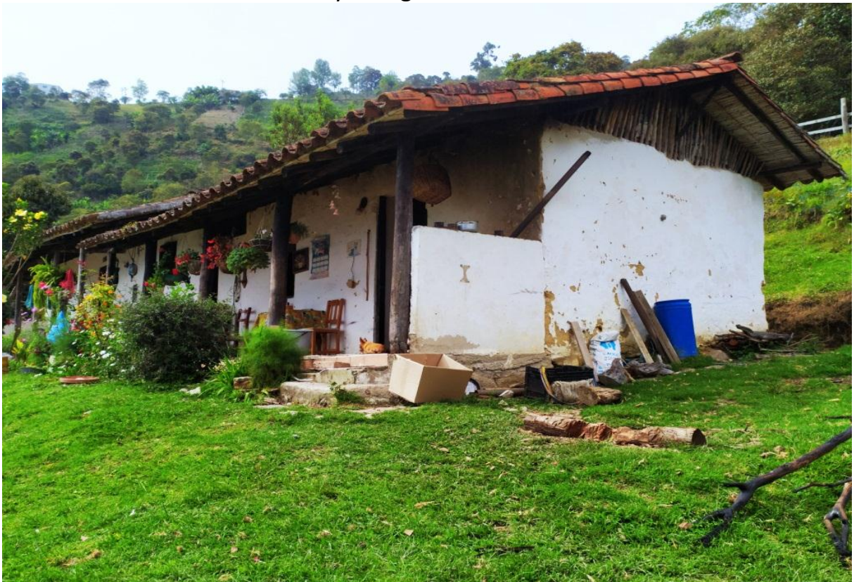
Fotografía (Exterior Casa de Habitación)
