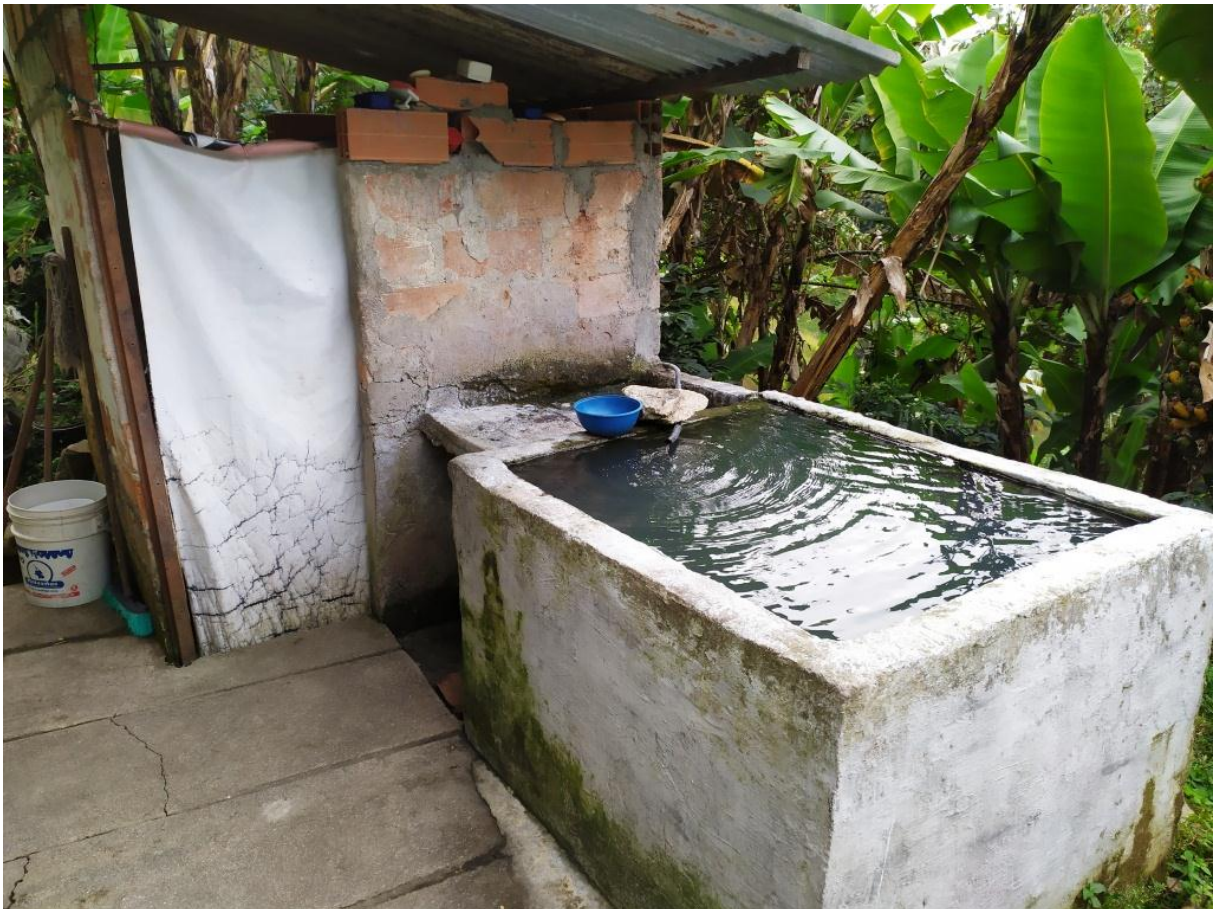
FOTOGRAFIA 14 (Casa de Habitación, Tanque – Lavadero, Baño).
