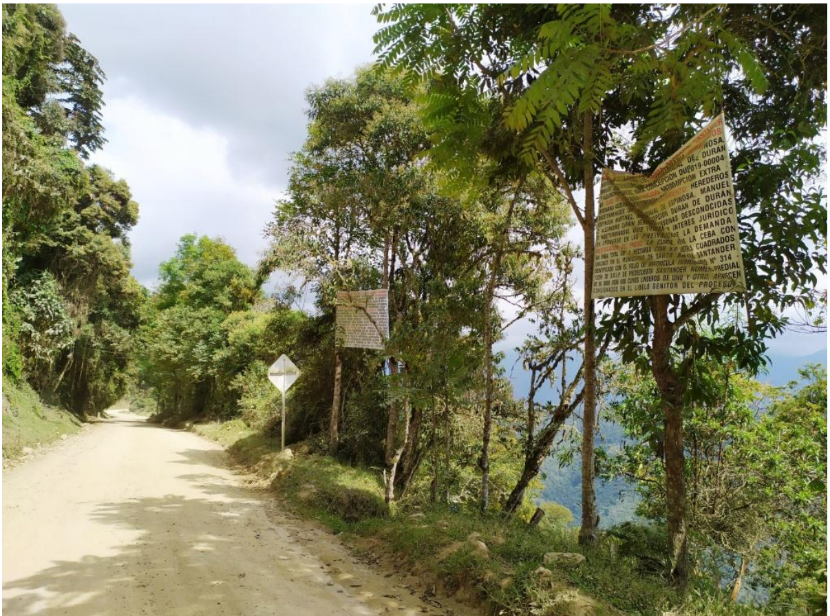
FOTOGRAFIA 1 (Instalación Dos (2) Vallas del Proceso, Vía Curos - Málaga).
