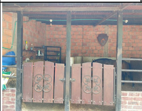
CONSTRUCCION 10 PARED AL FONDO
