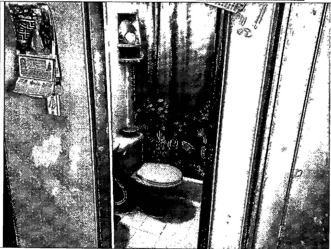
DETALLE DEL PREDIO.
