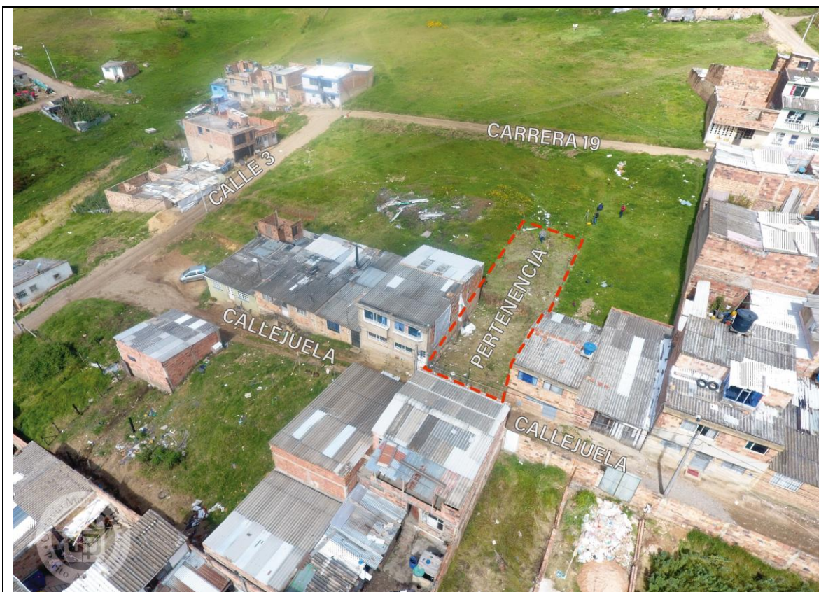
FOTOGRAFÍA AÉREA DEL PREDIO EN PERTENENCIA.
