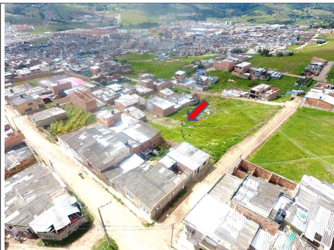
VISTA AÉREA GENERAL. CALLE 4 – CARRERA 19
