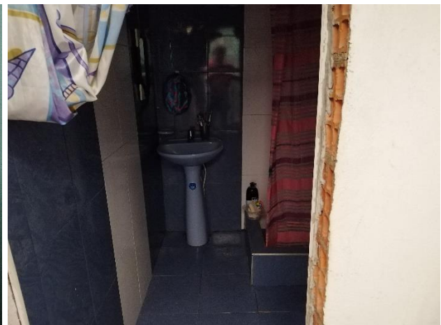
DETALLES DEL INTERIOR DE LA VIVIENDA.
