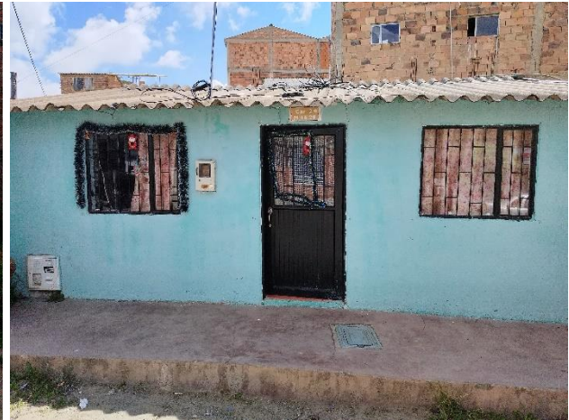
VIVIENDA CON MEDIDORES DE SERVICIOS.
