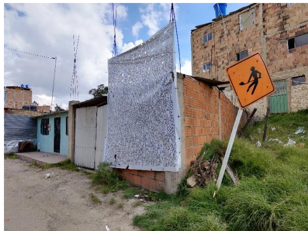
DETALLES DEL EXTERIOR DEL GARAJE/BODEGA.
