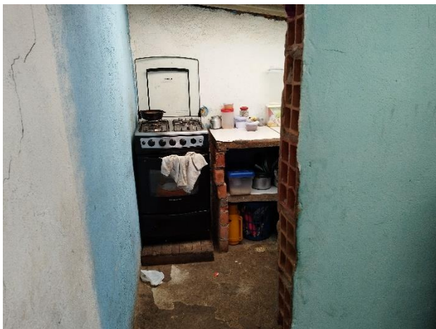
DETALLES DEL INTERIOR DE LA VIVIENDA.
