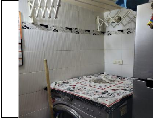
CURTO DE ROPAS MEJORAS EN PISO Y PAREDES
