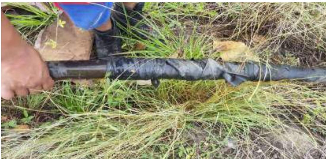
**Solución:** Cambiar toda la manguera de conducción en dos pulgadas, hasta llegar a los tanques.
