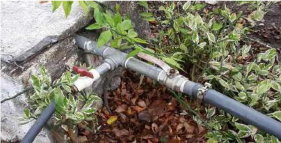
b) La manguera de conducción está totalmente rota a lo largo de los doscientos metros de recorrido, amarrada con alambre, con neumático, con uniones para la misma, con pedazos de tubo, y además se reduce de dos pulgadas a una y media. (Ver fotografías anexas)
