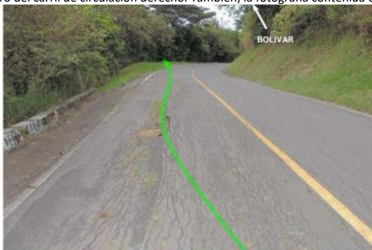
Fotografía N° 4: En esta imagen en sentido El Bordo-Bolivar, se observa la flecha de color verde la cual indica que una vez las llantas del vehículo cayo en el hueco, sufrió una rotura de la hoja de resorte anterior izquierda, lo que generó que el operador del vehículo perdiera el control del mismo.
