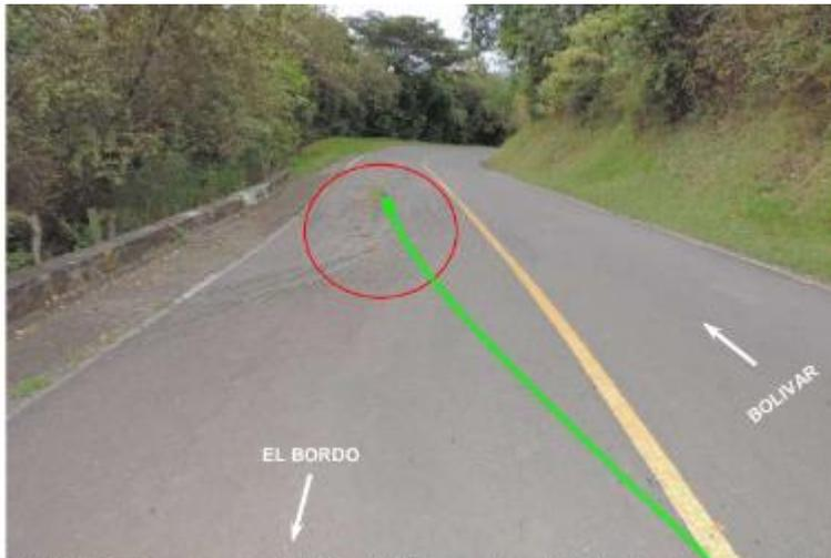
**Fotografía N° 3:** En esta imagen en sentido El Bordo-Bolívar, se observa la flecha de color verde la cual indica que las llantas del costado izquierdo caen al hueco o bache presente en el carril de sentido Bolívar-El Bordo
