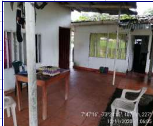
VISTA INTERNA CASA ADMINISTRADOR
