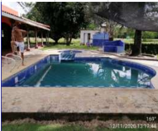
ESTADO DE LA PISCINA
