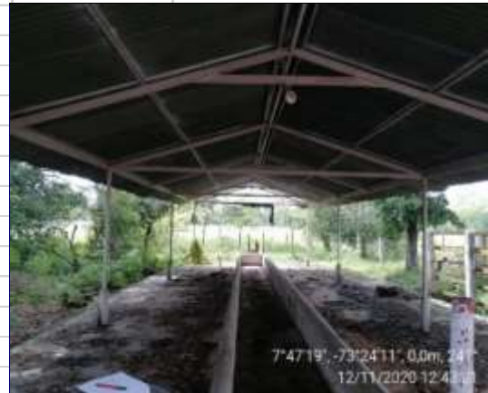
ARMAZON CUBIERTA COMEDERO
