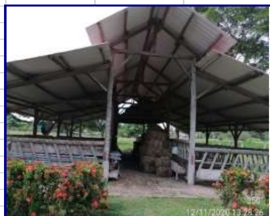
ASPECTO ARMAZON CUBIERTA
