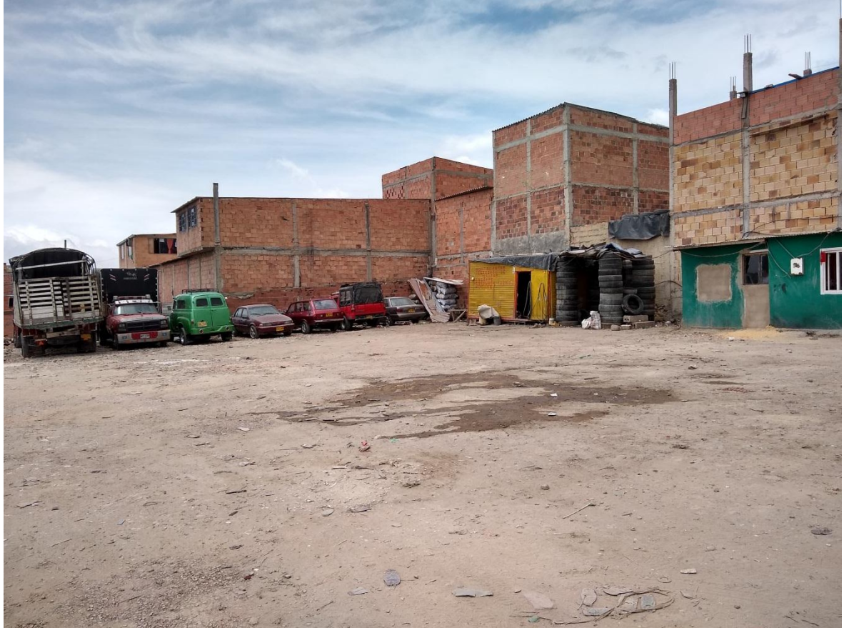
Foto No. 3 Predio pretendido en reivindicación denominado LOTE 22
