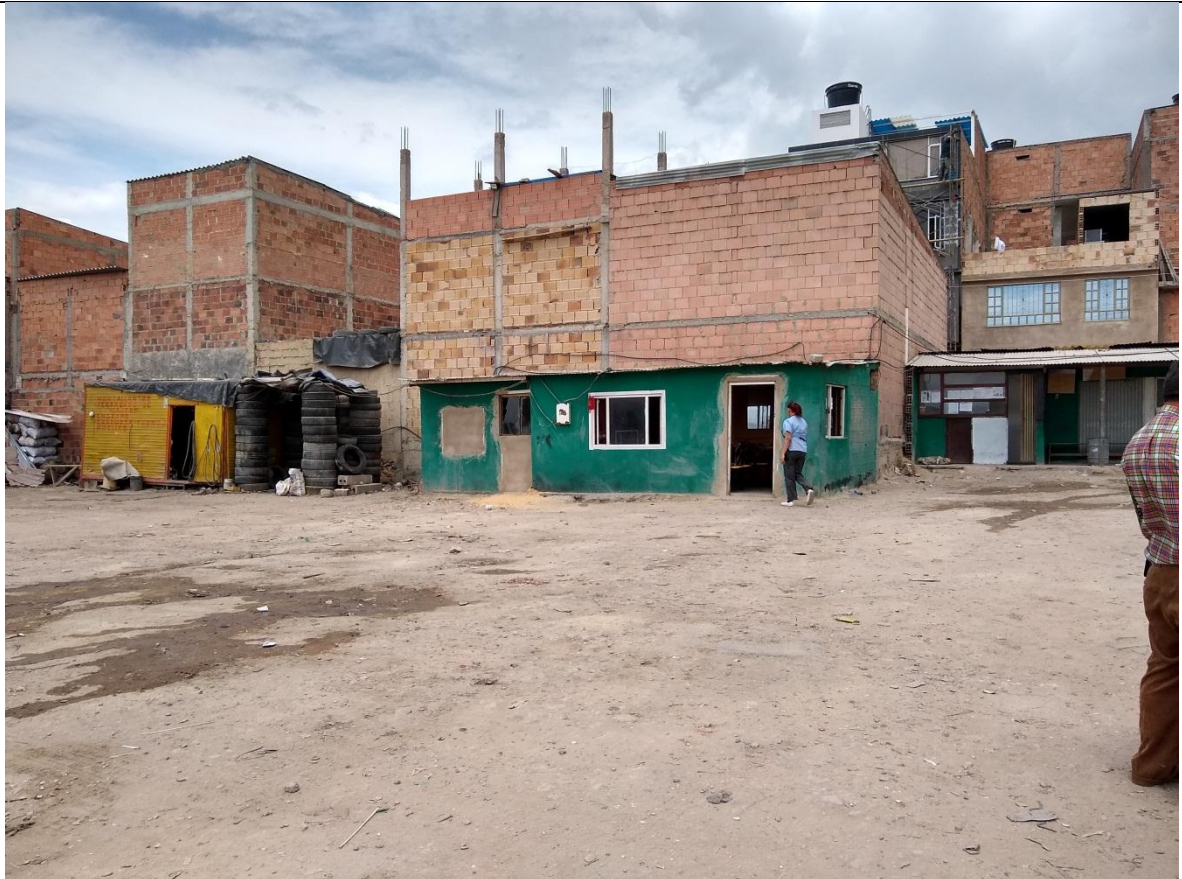
Foto No. 2 Zona pretendida en reivindicación que hace parte del predio de mayor extensión denominado LOTE 8
