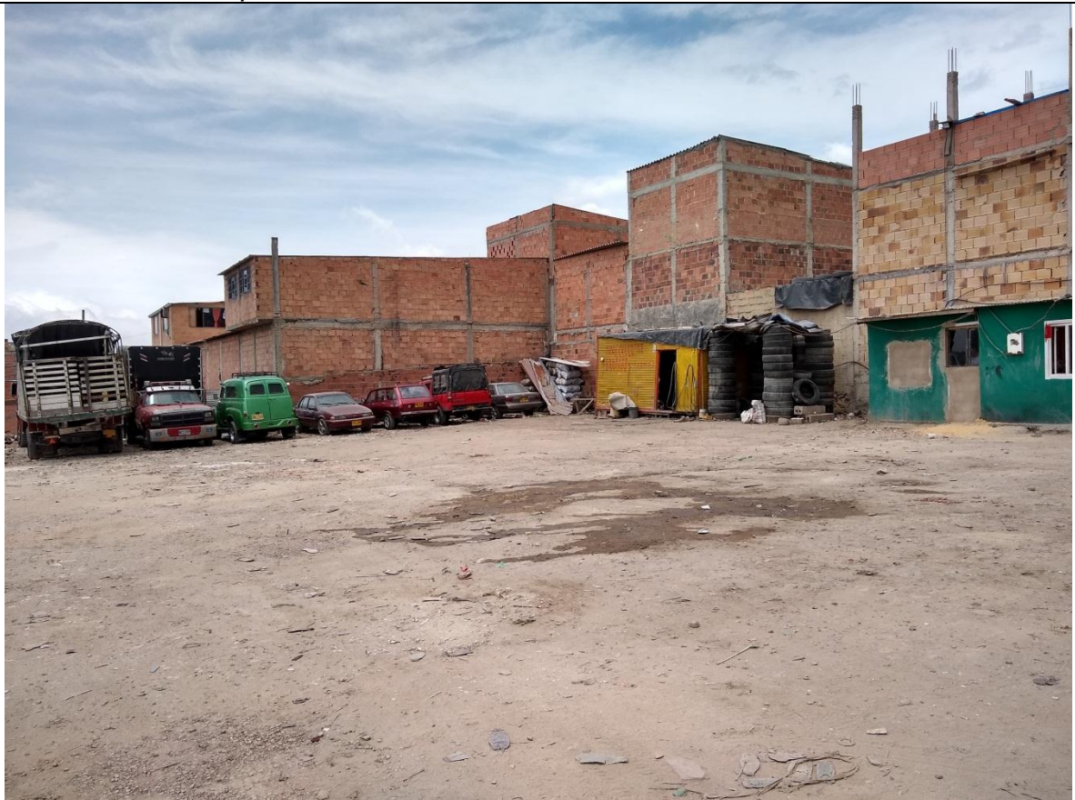
Foto No. 4 Predio pretendido en reivindicación denominado LOTE 23
