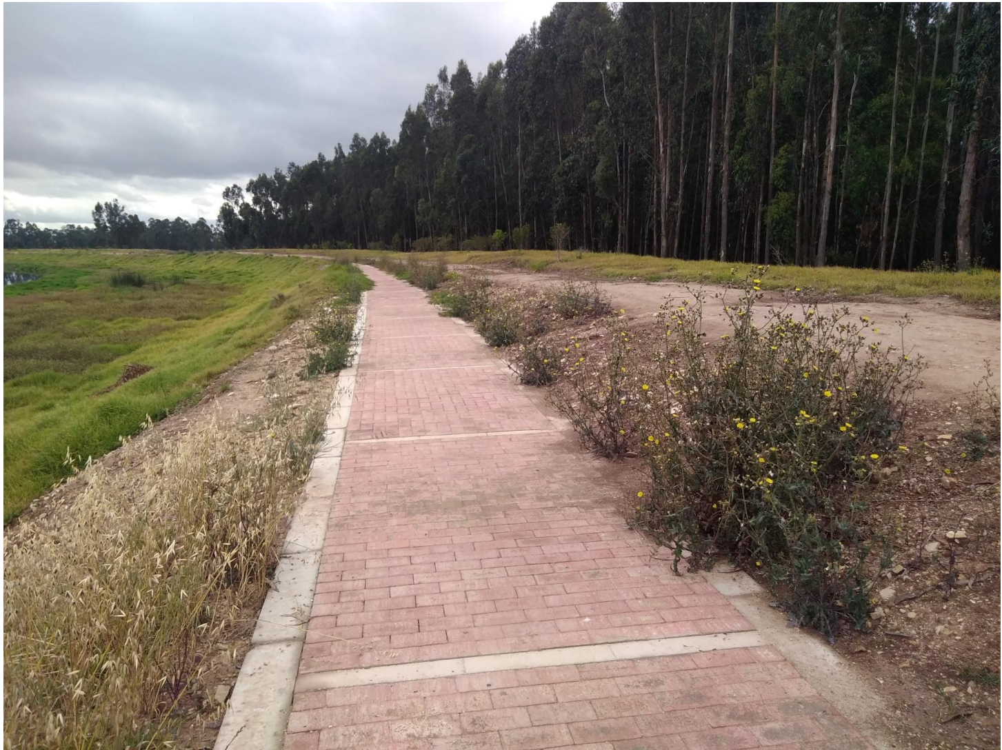
fotografia 1 VISTA CICLORUTA EN CONSTRUCCION
