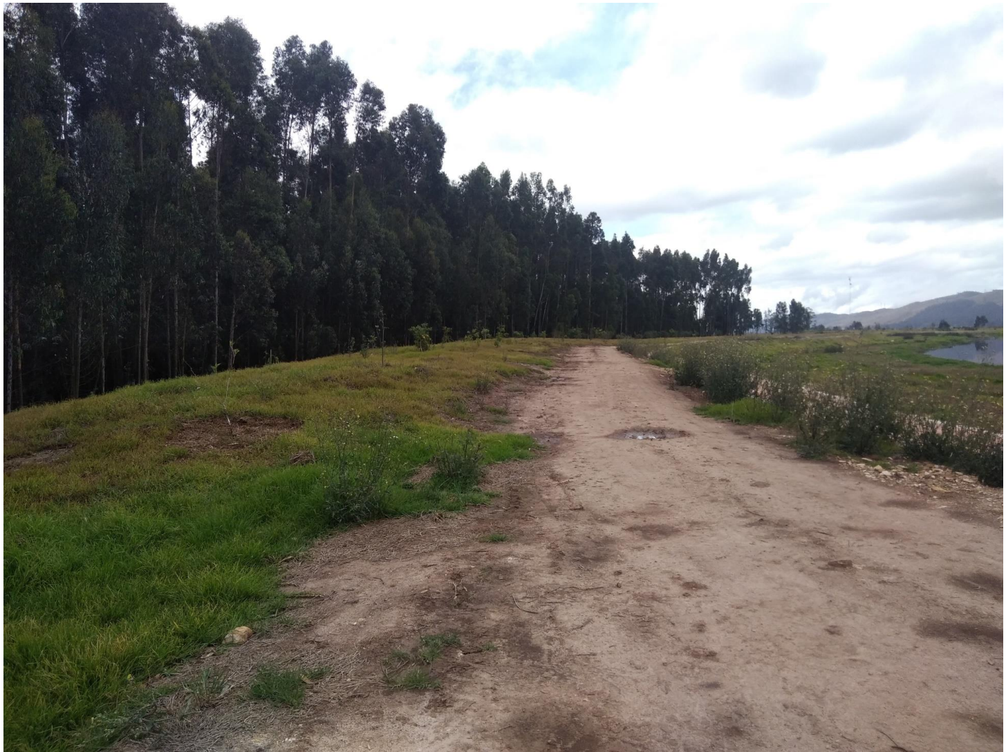
fotografia 5 DETALLE CALZADA EN CONSTRUCCION
