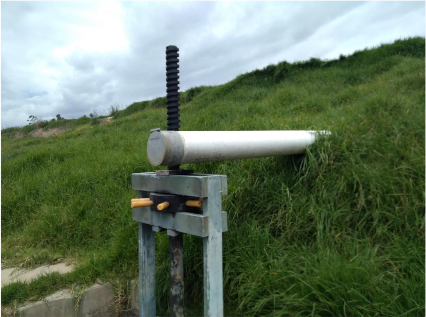
*FOTOGRAFIA 8 TUBO POR DONDE SE ELIMINA EL AGUA SOBRANTE EN PREDIO REMANENTE*
