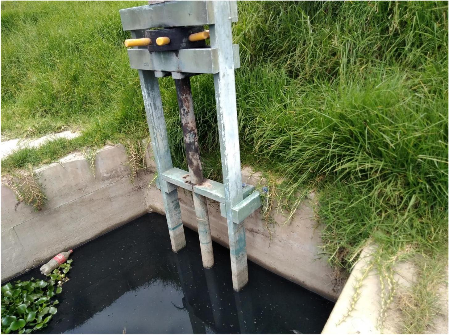
*FOTOGRAFIA 7COMPUERTA QUE PERMITE ENTRADA DE AGUA DEL RIO*
