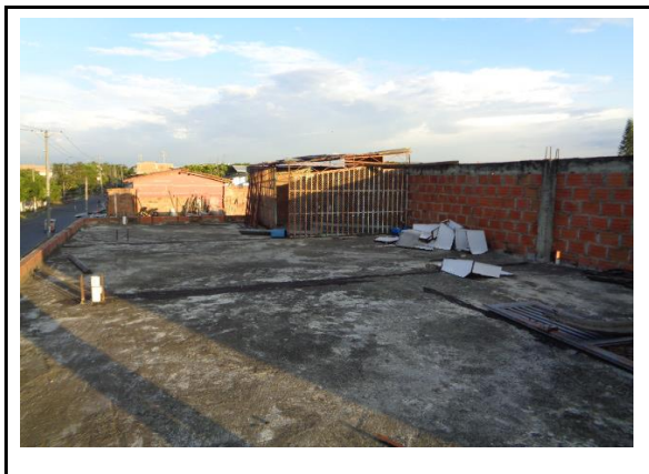
LOSA EN CONCRETO
