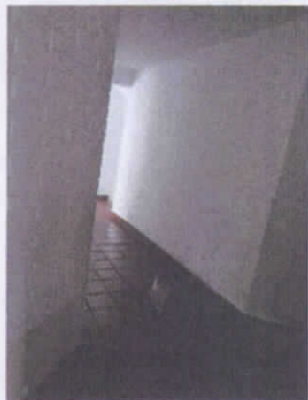
ACCESO AL APARTAMENTO
