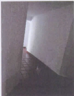
ACCESO AL APARTAMENTO
