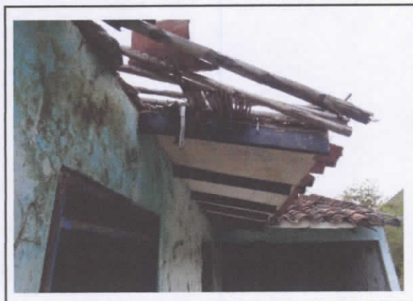
TECHO Y MUROS
