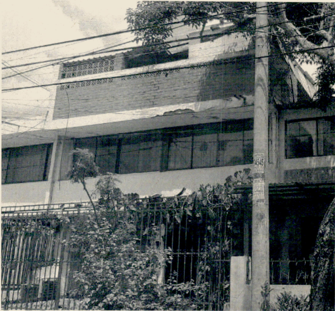
FRENTE DEL EDIFICIO "RINCON" P.H
