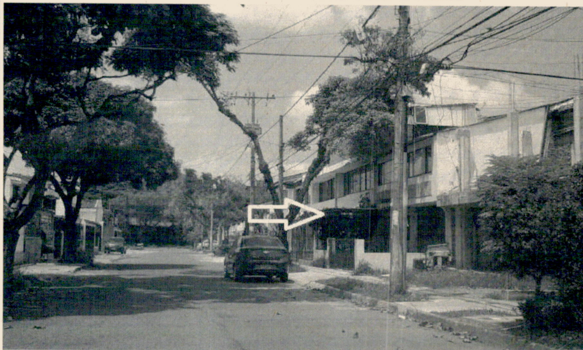
FRENTE EDIFICIO "RINCON" SOBRE LA CALLE 49 NORTE
