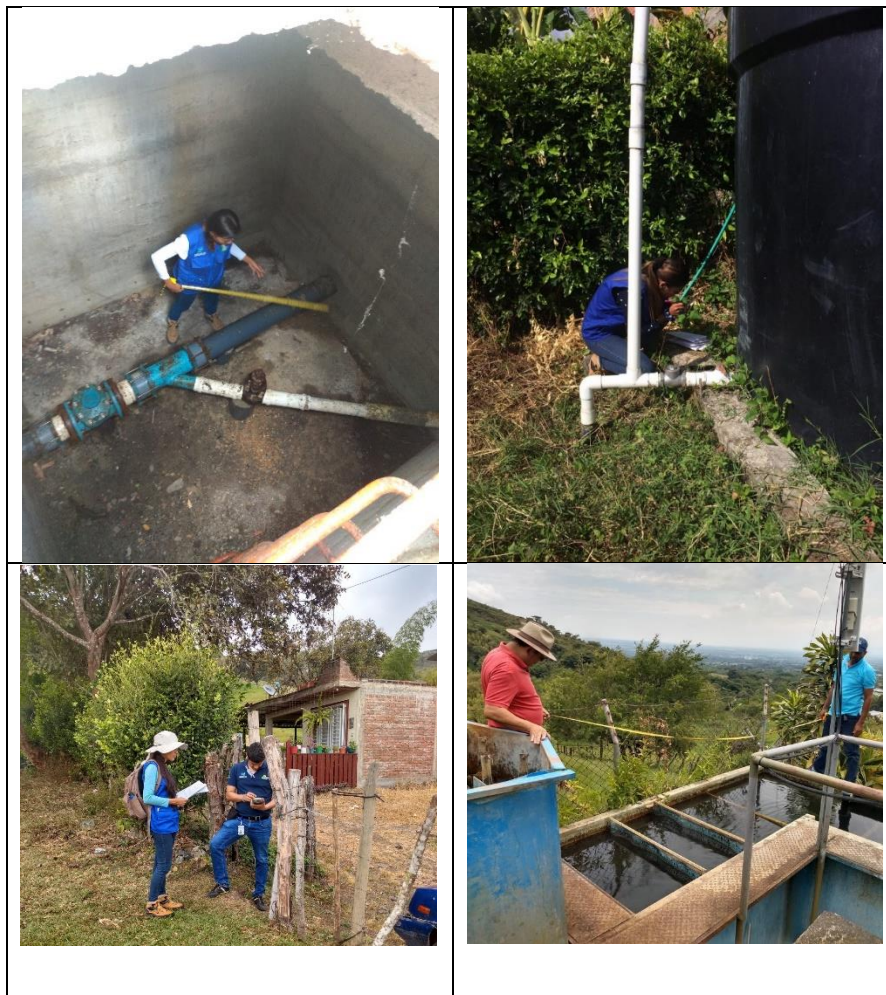
Figura 6 Registro fotográfico levantamiento de campo
