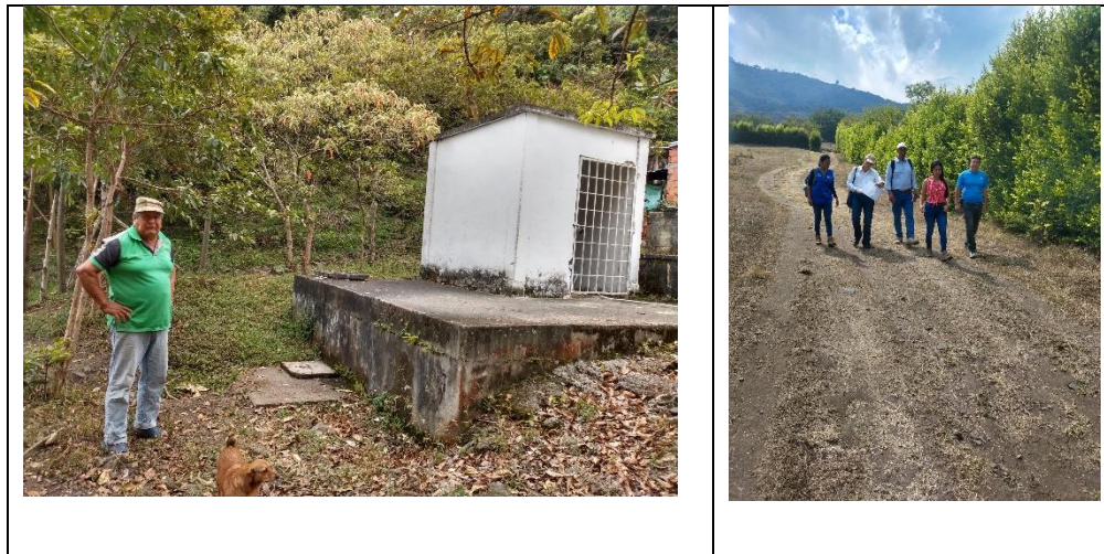
Figura 5 Registro fotográfico reconocimiento físico de Campo
