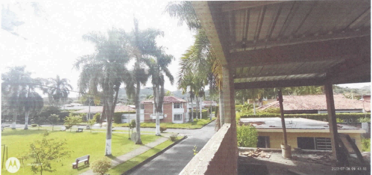
Ilustración 5.. se observa apertura para ventanas que dan a vía internas del conjunto residencial Rancho chico
