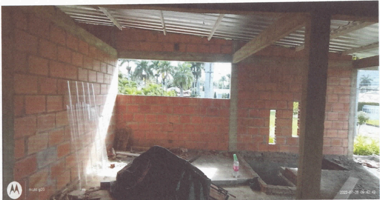
Ilustración 4. se observa interior de la construcción en el segundo piso.
