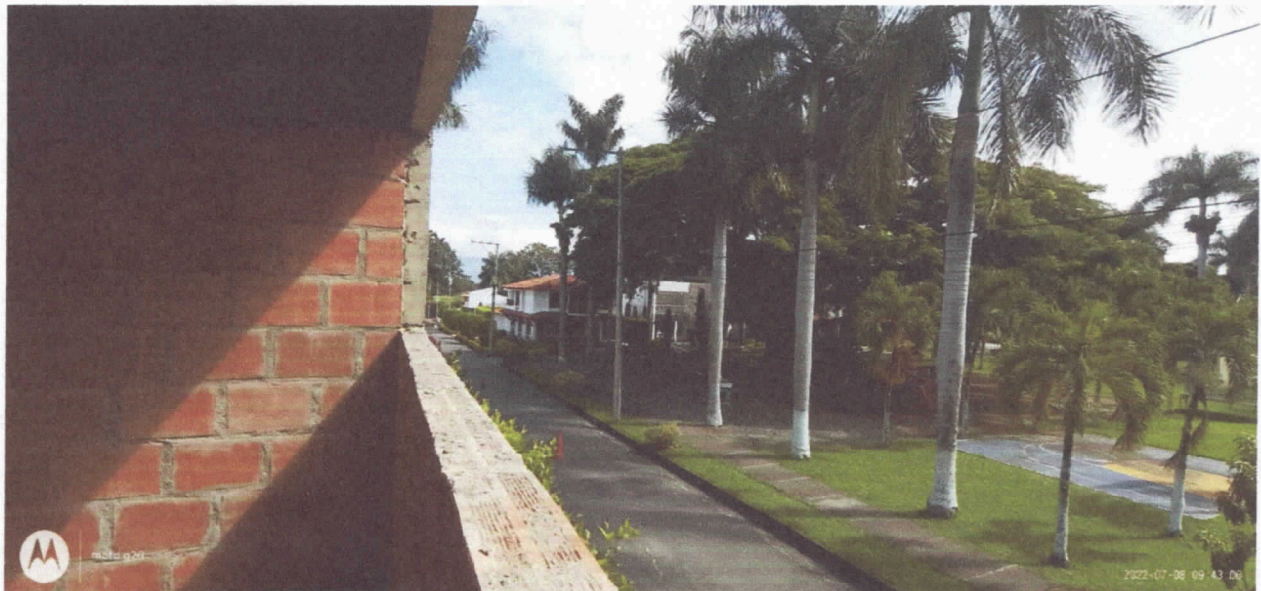
Ilustración 6. se observa apertura para ventanas que dan a vía internas del conjunto residencial Rancho chico.
