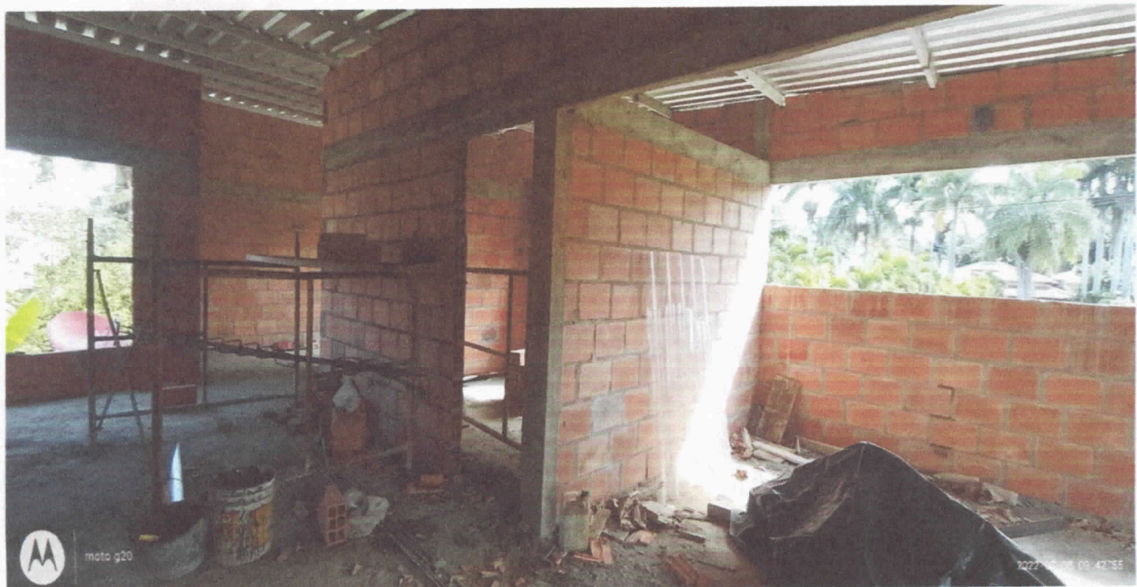
Ilustración 3. se observa paredes en ladrillo y cubierta o techo en hojas, en obra negra.
