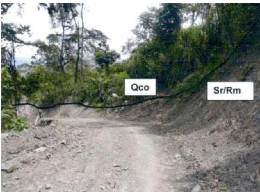
Fotografías 3 y 4. Aspectos de los horizontes de suelo residual (Sr) y roca meteorizada (Rm), presentes en algunos sitios de los alrededores del sitio de estudio,
