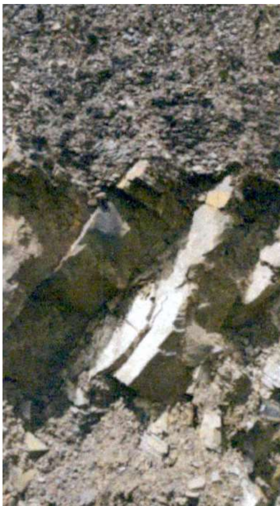
Foto: Zona en donde aflora la roca. Se realiza un contacto con el material altamente meteorizado de baja consistencia y baja estabilidad
