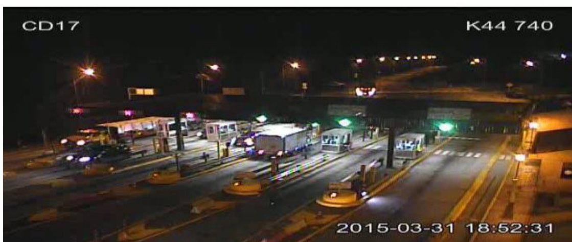
Foto. 213. Paso del vehículo por la estación de Peaje Puente Quetame.
