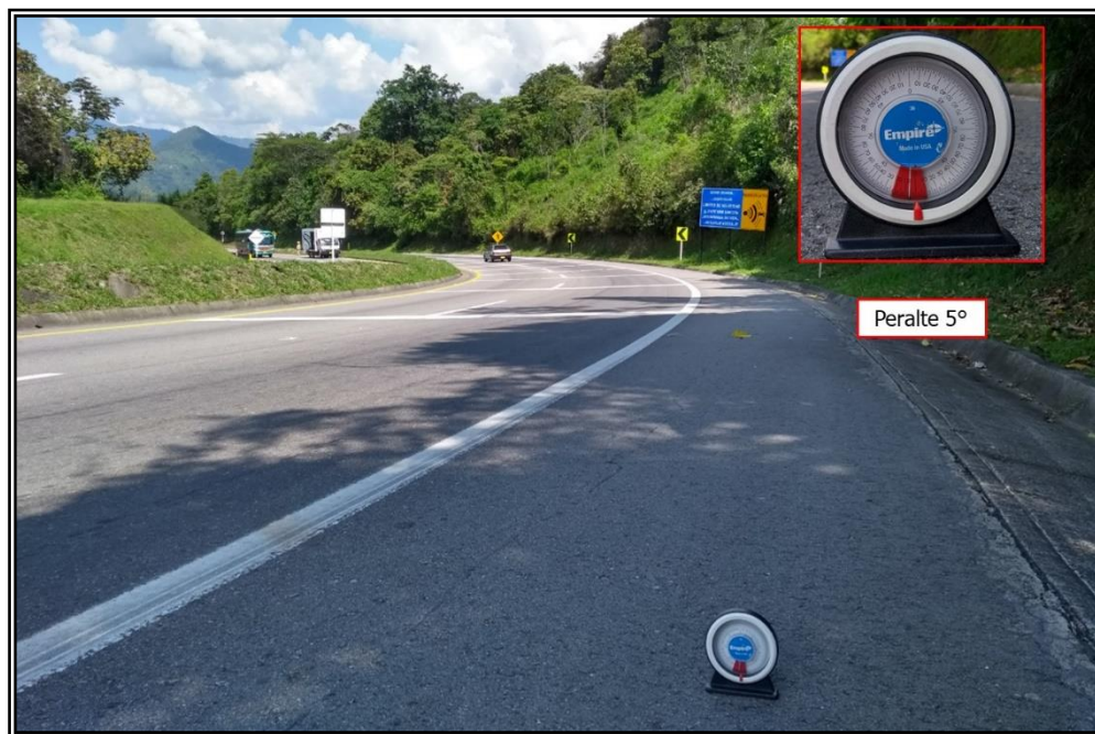
Imagen 2.6 Condiciones de la vía.
