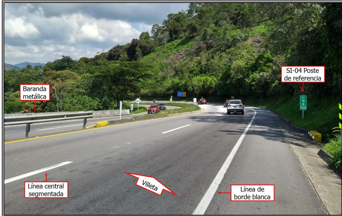
Imagen 2.2 Condiciones de la vía
