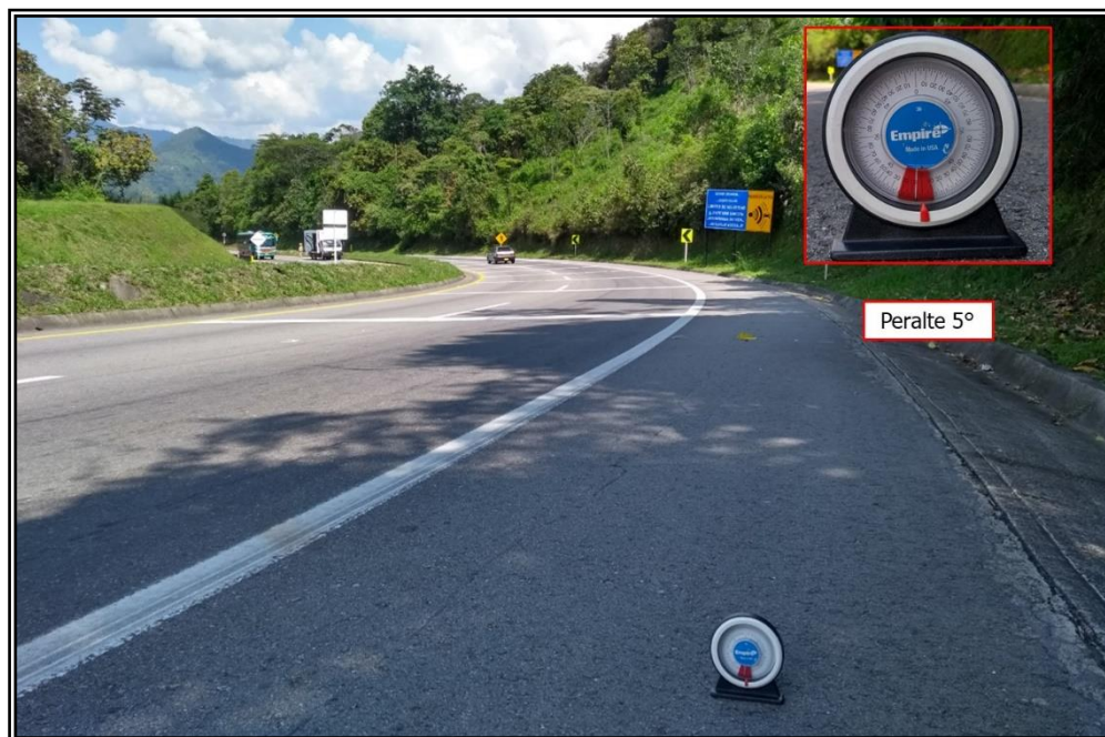
Imagen 2.6 Condiciones de la vía.
