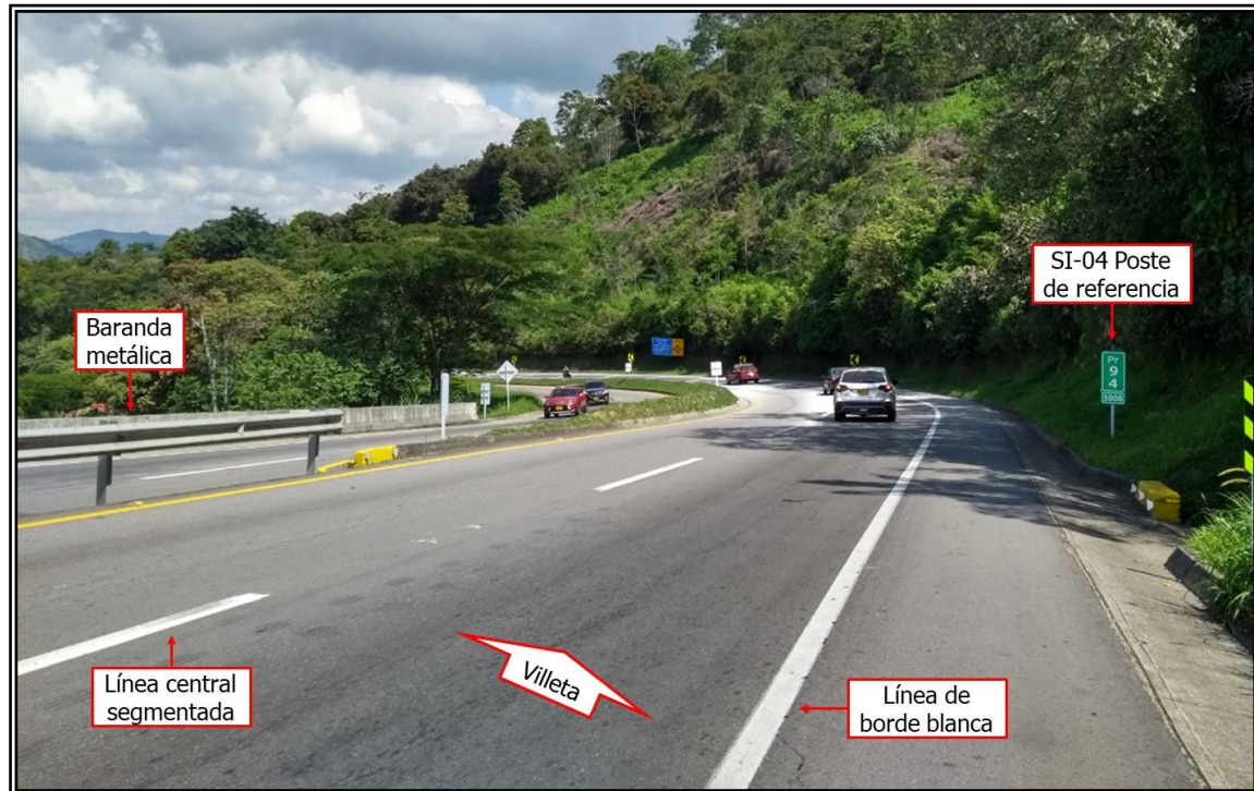
Imagen 2.2 Condiciones de la vía
