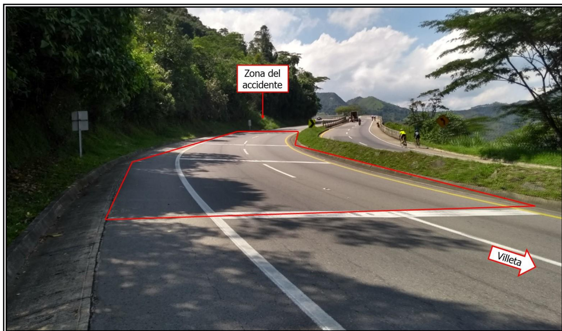
Imagen 2.5 Condiciones de la vía.
