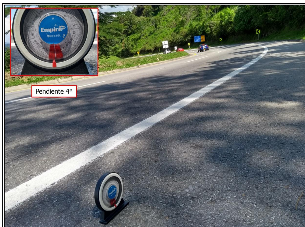
Imagen 2.7 Condiciones de la vía.
