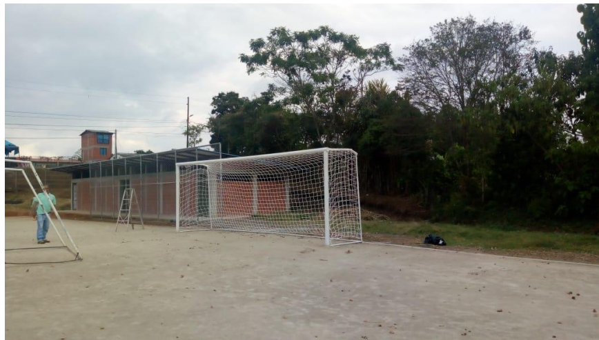
Portería de fútbol fija suministrada e instalada en el marco del Contrato de Obra No. LP-004 de 2017
