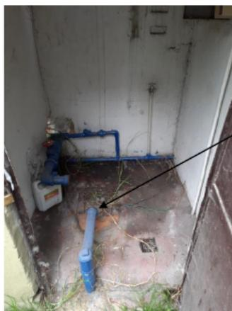
En esta imagen se observa la Caseta de bombas existente, en donde claramente se ve que no es el cuarto con las condiciones adecuadas de tamaño para ubicar las nuevas bombas. Por lo anterior ya se había solicitado a la entidad, el suministrar un isométrico, planta y cortes de las bombas a instalar. A mi concepto toca realizar un nuevo cuarto de bombas y chequear las redes eléctricas de conexión de las bombas.
