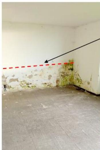
Se necesita realizar un corte en paredes, primero con el fin de que no se vaya a afectar pañete en la parte que no tiene filtración, y además con el fin de garantizar un acabado óptimo en la ejecución de la actividad.
