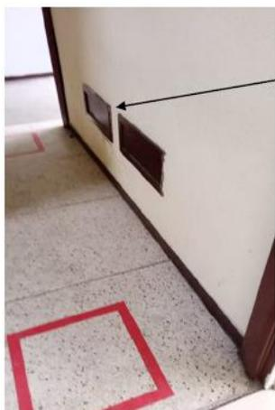
Espacio insuficiente entre las dos cajillas de medidores existentes para permitir el paso del bajante que alimenta todos los apartamentos por gravedad. Tocaría reacomodar las cajillas de tal forma que permita el paso del bajante de acuerdo al diseño entregado por la entidad. Ver detalle ZONA 1
