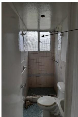
En esta foto y según indicaciones dadas por la supervisión, el cieloraso va a quedar descolgado unos 20-25 cms. Esto implica tener que desmontar ventanas, realizar un dintel superior, una alfaja y reponer la ventana existente por una de similares características o en aluminio de menores medidas a la existente. Se requiere que la entidad de las directrices a seguir al respecto.
