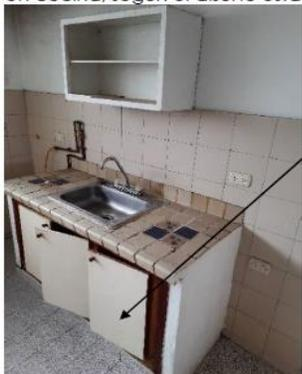
Se necesita realizar el desmonte de muebles bajos para realizar el cambio de redes hidrosanitarias de la cocina, y por consiguiente permitir la correcta realización de las obras en mención.
