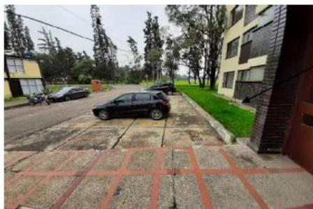
Se necesita realizar la demolición de placa en concreto en estas zonas donde según el diseño sanitario salen las redes de desagüe de los apartamentos.
