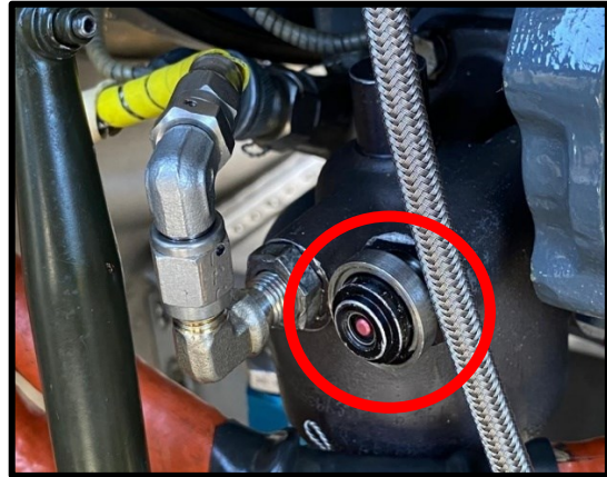
Fotografía No. 26: Imagen de REFERENCIA detallada del indicador de presión diferencial
