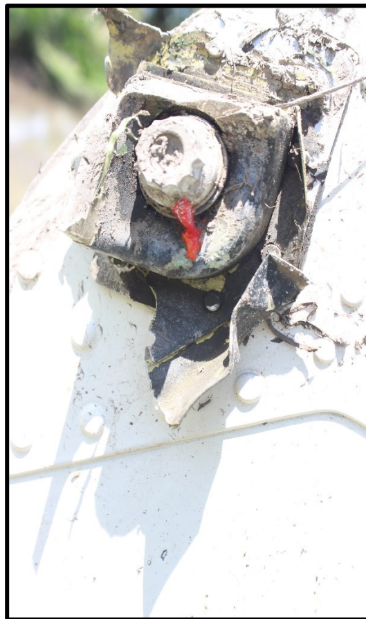
Fotografía No. 51: Vista de detalle puntos de fractura de la sección Tail Boom PNC 0741
